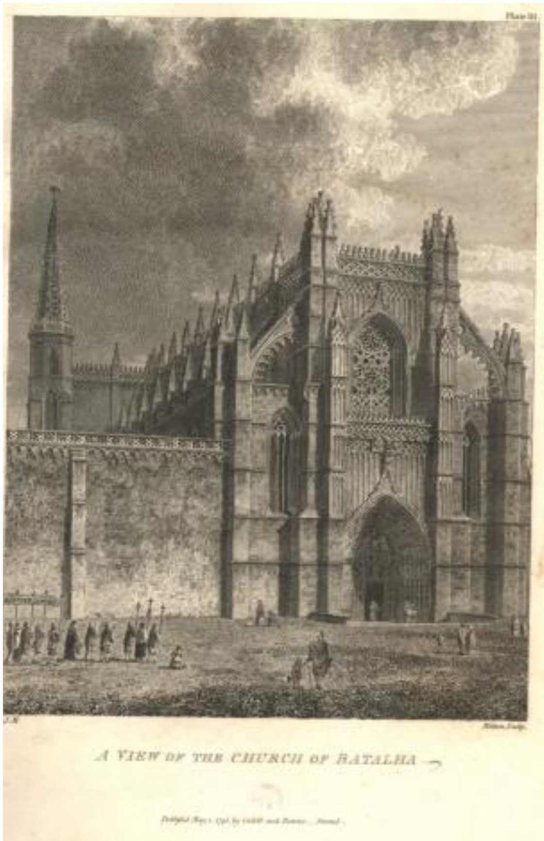
Figura 4: Uma vista do Monastério de Batalha
