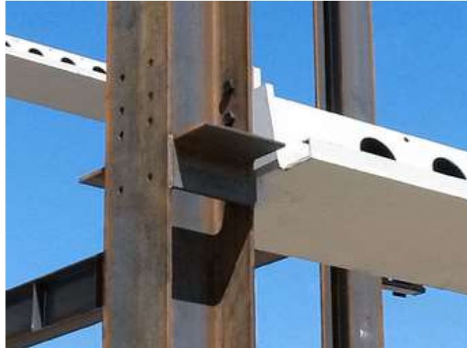
Figura 37- Ligação parafusada entre viga e pilar metálico
