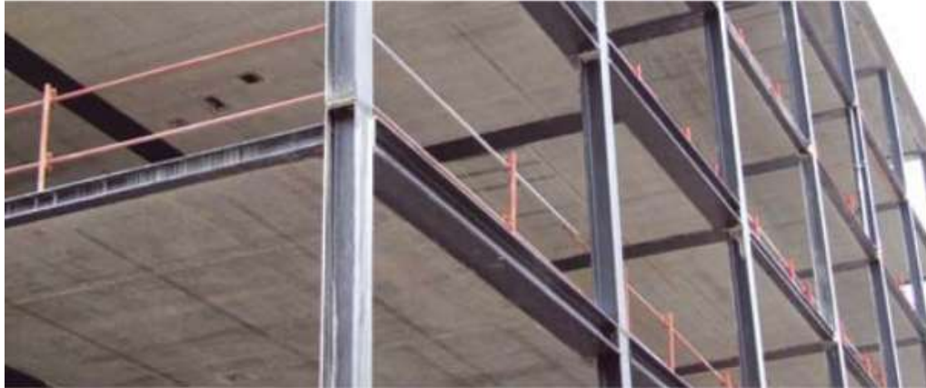
Figura 42- Laje do edifício Cité Internacionale
