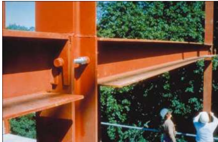
Figura 29- Detalhe da ligação
