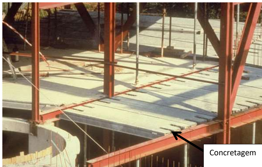
Figura 14- IFB com laje pré-moldada alveolar pronta para concretagem
