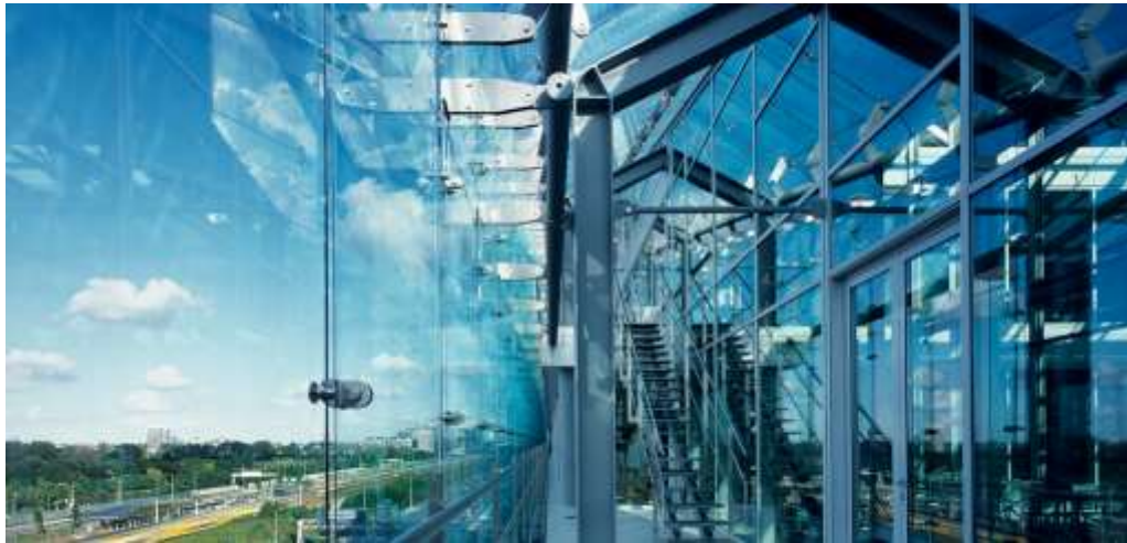
Figura 40 – Detalhe interno da fachada
