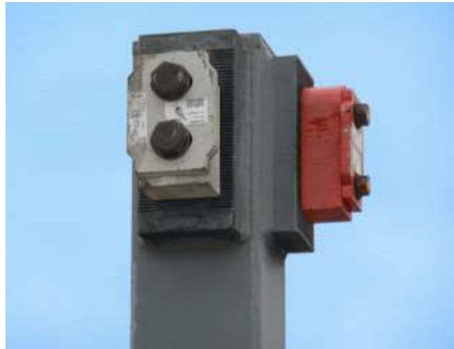
Figura 36- Pilar pronto para receber a viga
