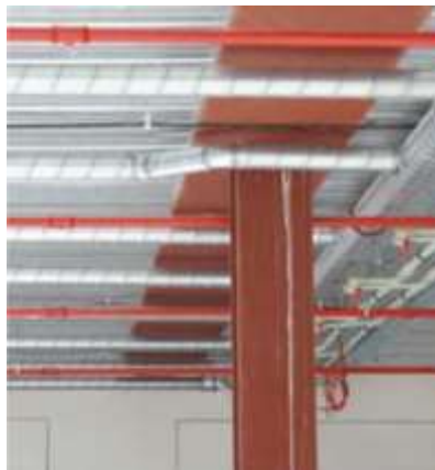
Figura 43- Laje com a passagem de dutos
