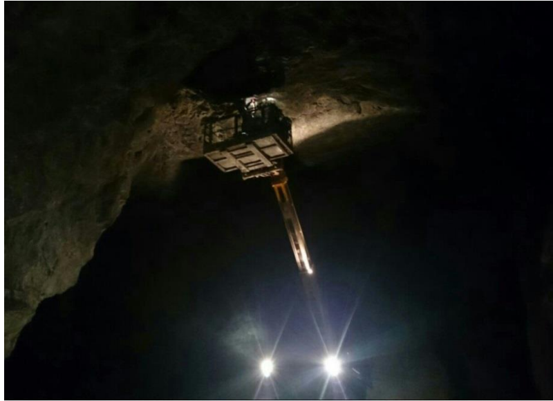
Figura 5.13 - Instalação do refletor do sensor de convergência no teto da galeria.
