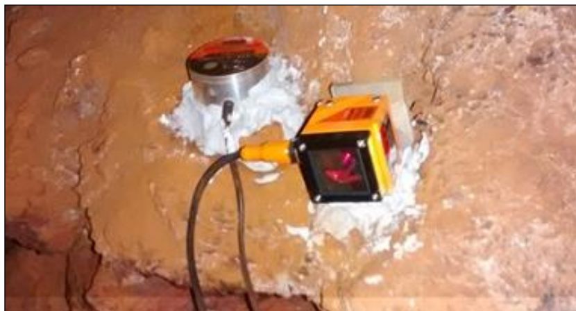
Figura 4.11 - Sensores de vibração - geofone (esquerda) e de deslocamento (direita) fixados nas paredes da cavidade com gesso - Gontijo et al., (2016a).
