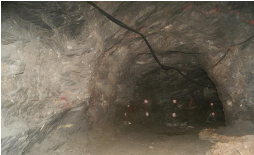
Figura 5.3 - Galeria de instalação do SMDR juntamente com 03 seções de convergência convencionais utilizadas pela Mina Cuiabá - Gontijo et al., (2014).
