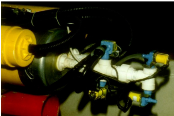
Figura 13 -Torre de válvula localizada à ré do VSI-01
