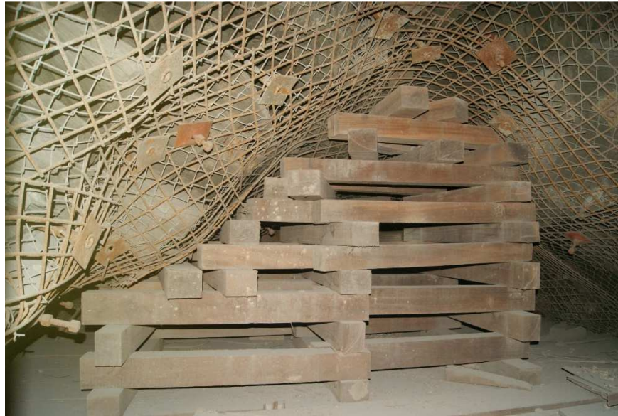
Figura 3.24: Aplicação de "fogueiras" na estação de carga da mina em associação a reforços, cambotas rígidas e telamento eletrosoldado.
