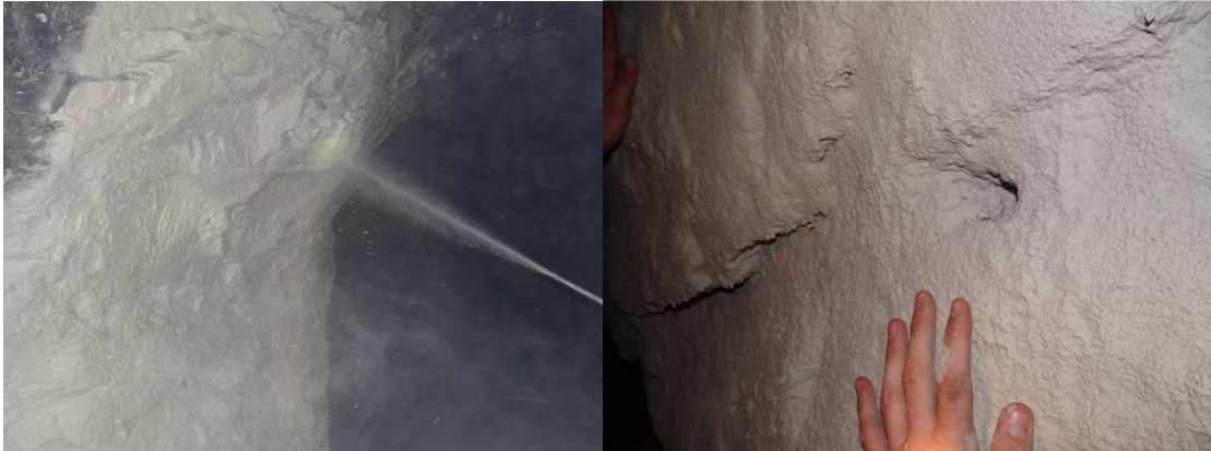
Figura 3.26: Aplicação de TSL em galeria da Mina Cuiabá no Nível 15 durante testes em 2012.
