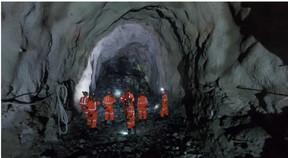
Figura 5.6: Face detonada da rampa Fonte Grande Sul no dia 26/maio/2016, ilustrando a aplicação de concreto projetado no ciclo do desenvolvimento da rampa do Nível 19.
