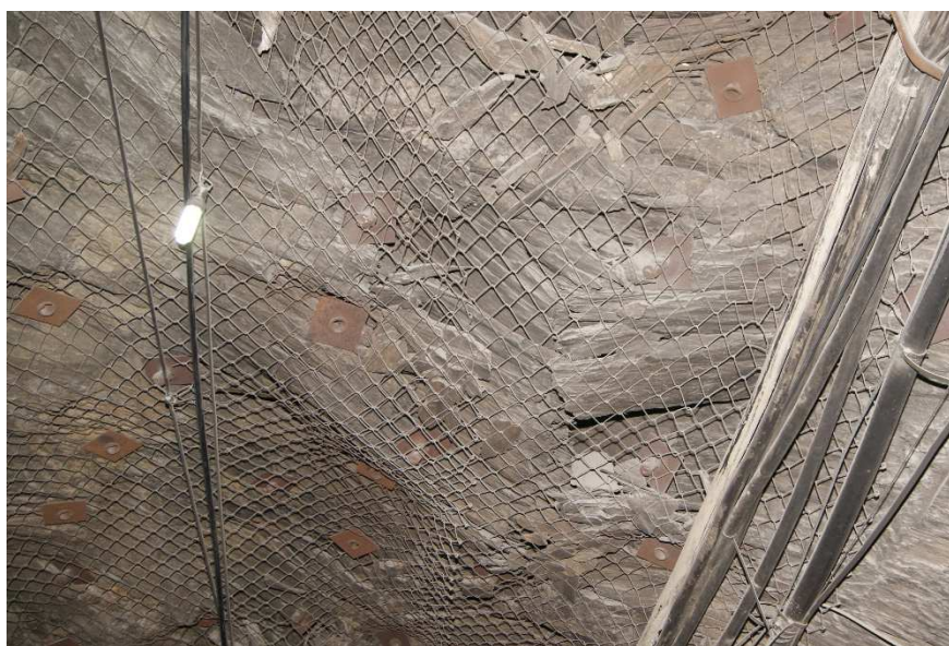
Figura 3.23: Tela aplicada em escavação da Mina Cuiabá, ao longo da rampa do nível 13 Fonte Grande Sul.
