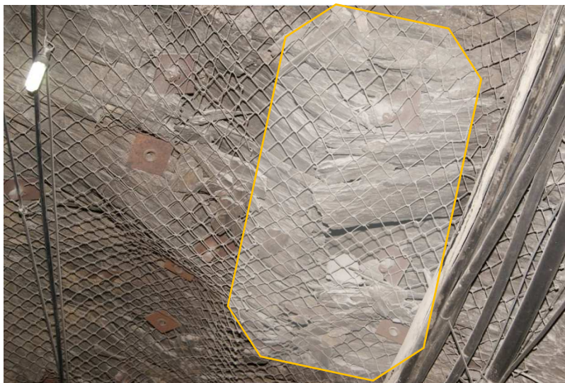
Figura 5.3: Evidência de buckling entre os níveis 13 e 14 da rampa Fonte Grande Sul, sem evidência de overbreak devido a presença de suporte de superfície (Pereira,2014).
