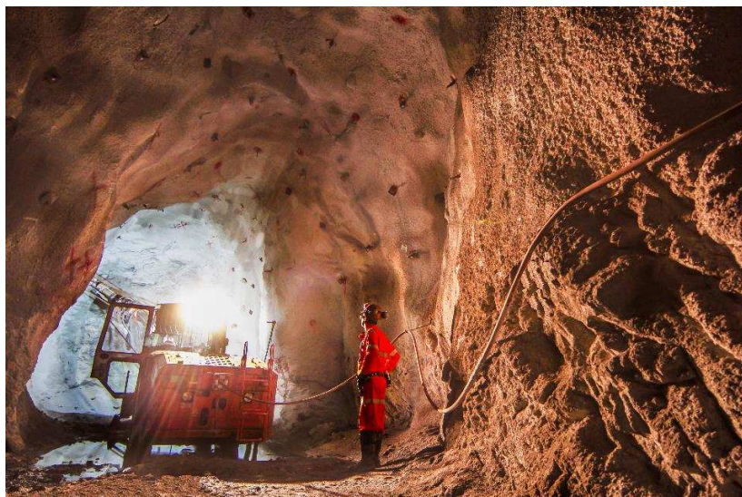
Figura 3.29: Galeria em desenvolvimento com aplicação de concreto projetado como sistema de suporte conjugado a reforços do tipo tirante resinado na Mina Cuiabá.
