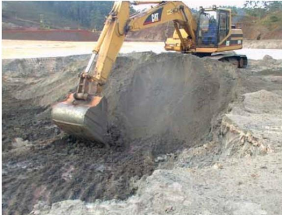
Figura 2.6 - Aspecto do rejeito após a drenagem (CBDB, 2011).
