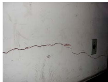
Figura 15 - Trinca horizontal.
