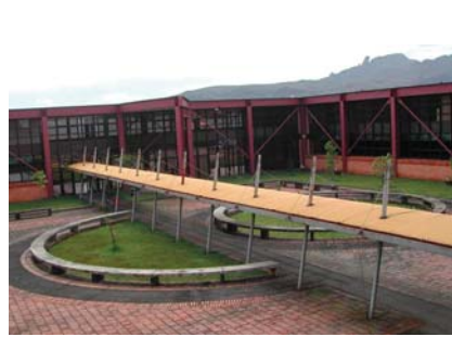
Figura 2 - Pátio interno e passarela central.
