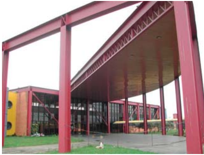
Figura 1 - Fachada principal da EM/UFOP.
