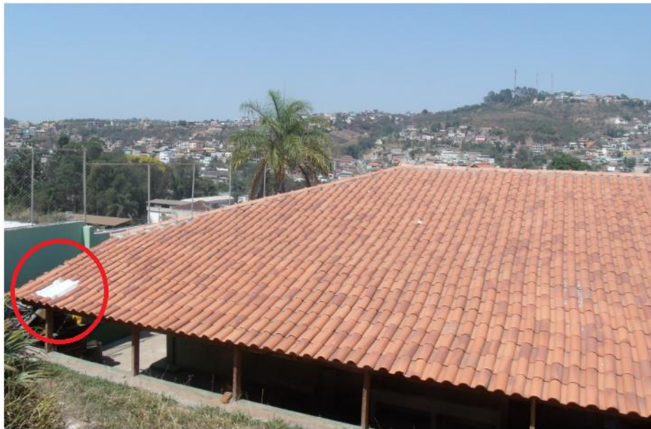
Figura 6.1 – TNT sobre o telhado de uma escola, no centro urbano de Congonhas, MG, instalado para receber a poeira que provavelmente seria depositaria. Fonte: Autor.
