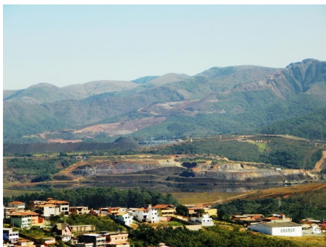
Figura 5.4 – Vista (para NW) dos contrafortes minerados, com a barragem de rejeitos limítrofe à periferia urbana de Congonhas.
