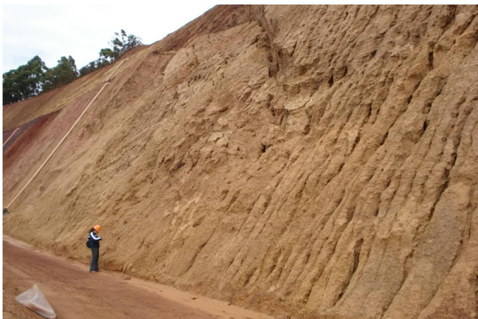
Figura 31 - Ruptura circular no filito dolomítico observada no ponto de amostragem A3.
