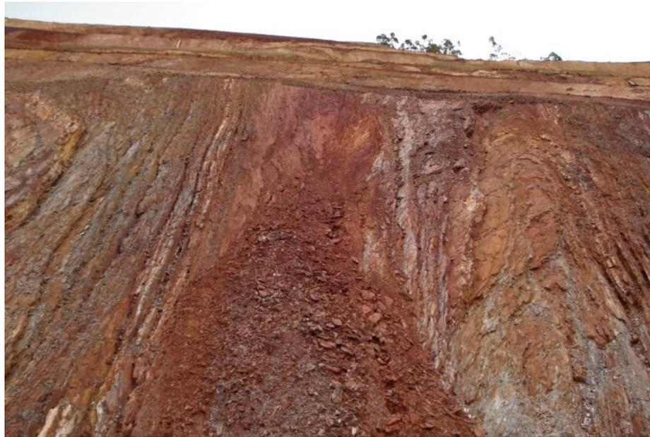
Foto 35 – Ruptura circular no filito sericítico identificada no ponto de amostragem A5.
