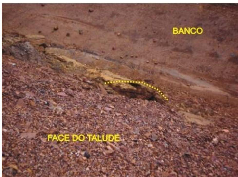
Foto 33 – Ruptura por flambagem no filito dolomítico observada no ponto de amostragem A4 (Notar embarrigamento da massa de rocha na face do talude).
