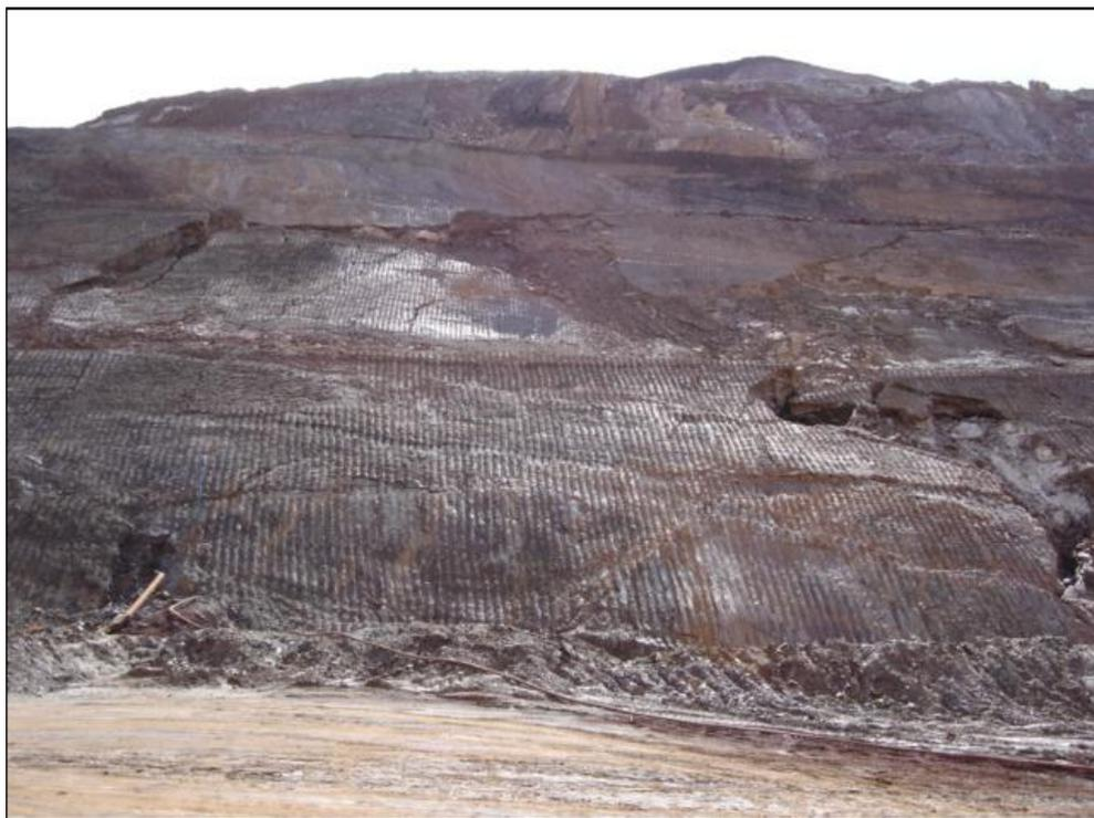
Figura 9 – Vista longitudinal da ruptura por flambagem ocorrida na Mina Pau Branco (Vallourec & Mannesman).
