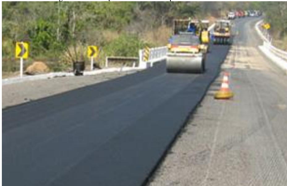
Figura 1 - Execução de trecho com pavimento de ardósia
