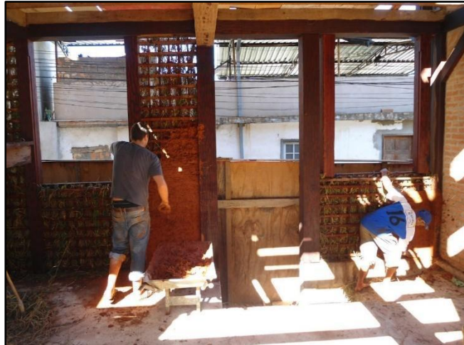
Figura 21 – Entrada do local mina Du Veloso em construção
