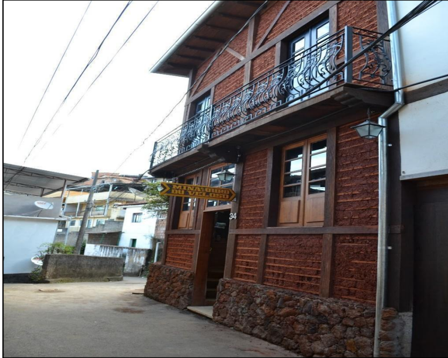
Figura 18 – Fachada da Mina do Veloso após recuperação do espaço
