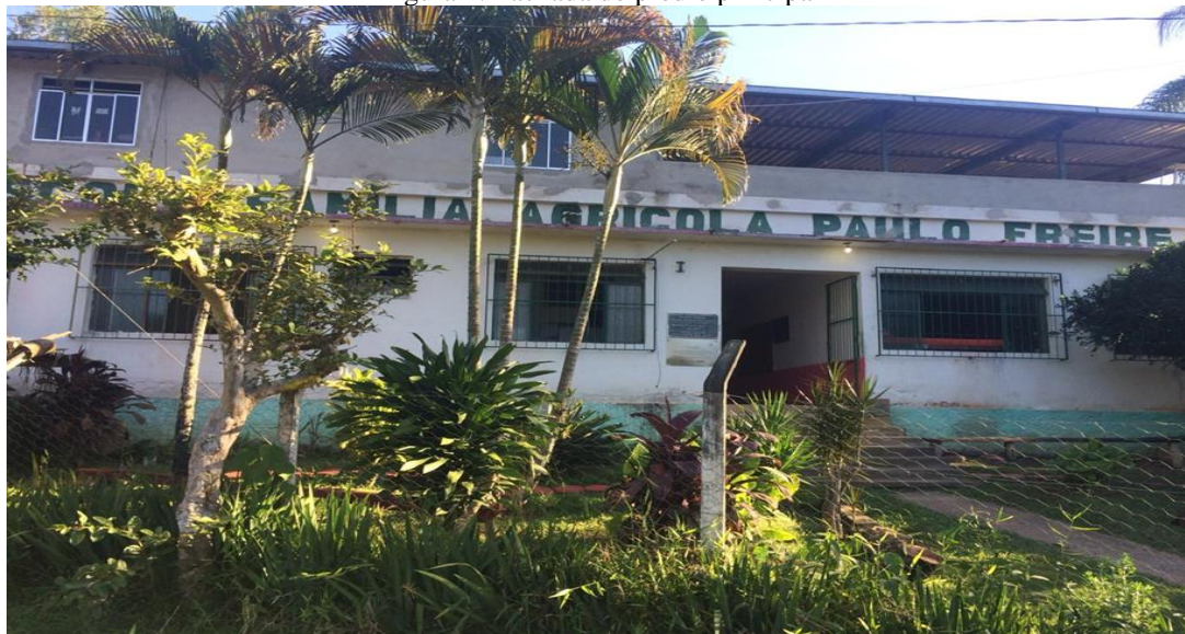
Figura 1: Fachada do prédio principal
