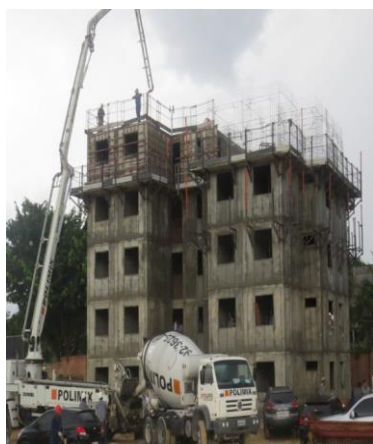
Figura 10 (a) – Concretagem do último pavimento.
