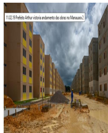
Figura 10 (c) – Edifício em fase de acabamento.
