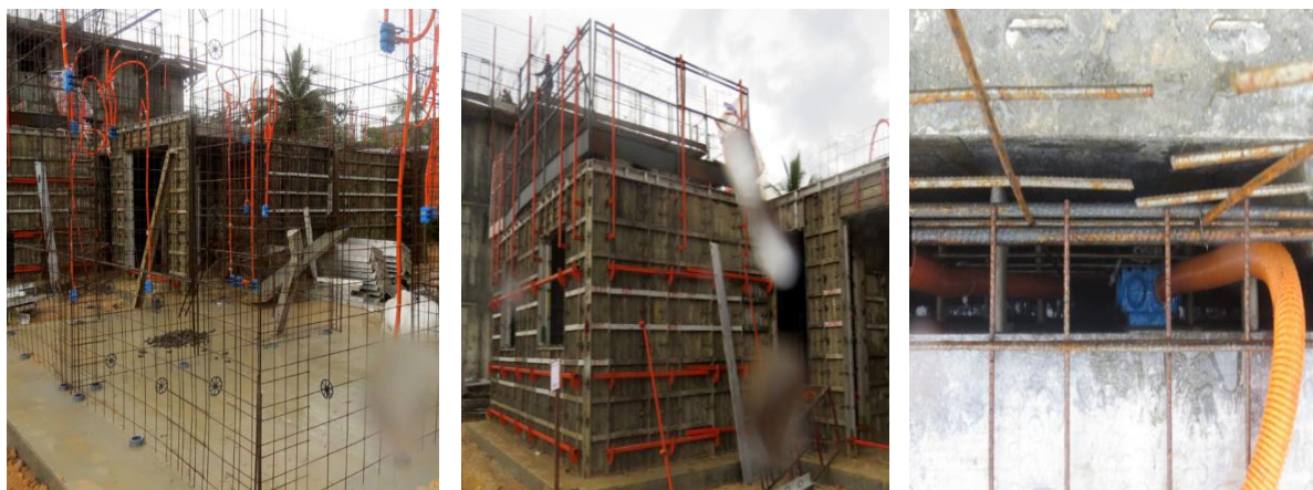
Figura 9 (a) – Instalação da armadura.
