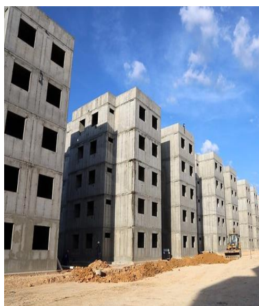
Figura 10 (b) – Estrutura finalizada.
