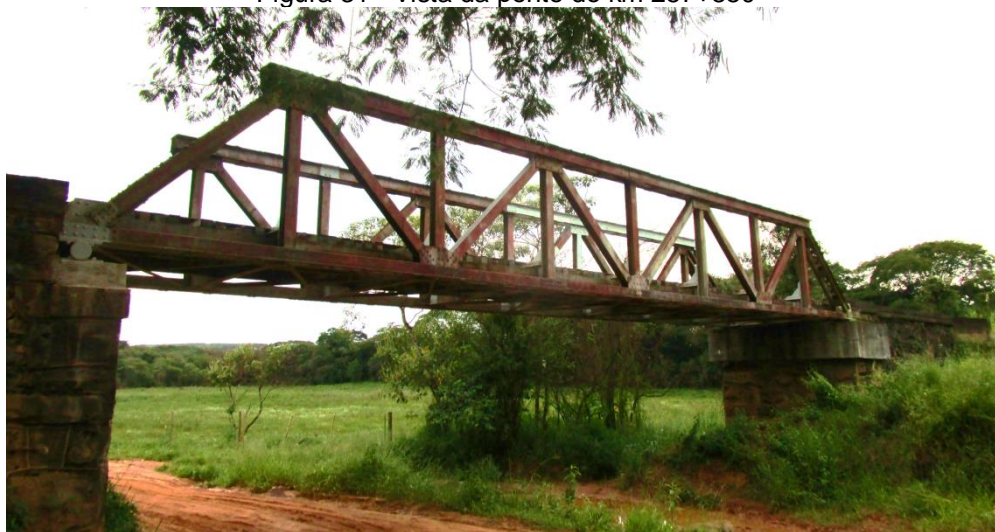
Figura 31 - Vista da ponte do km 257+850
