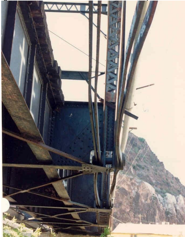
Figura 27 - Dano na corda inferior causado por enchente
