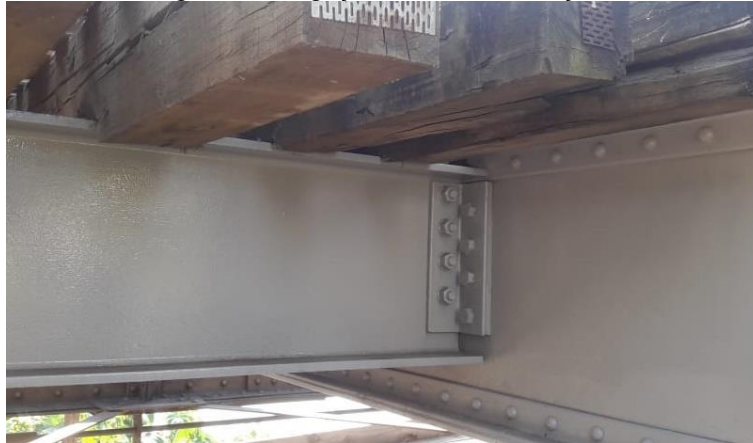
Figura 12 - Ligação em boas condições
