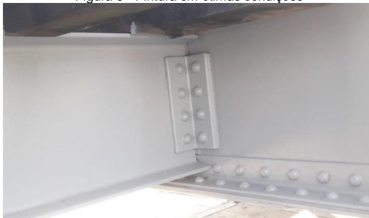
Figura 6 - Pintura em ótimas condições
