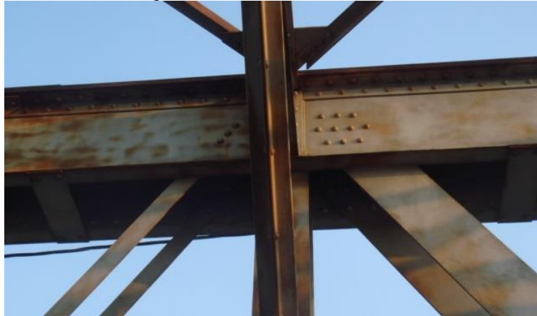
Figura 7 - Corrosão uniforme
