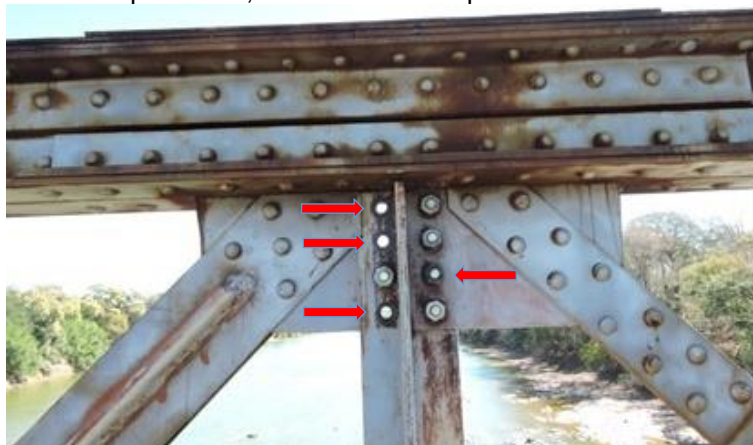
Figura 17 - perda de três parafusos, caracterizando a perda de mais de 1/6 dos parafusos
