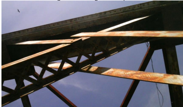
Figura 28 - Diagonal rompida
