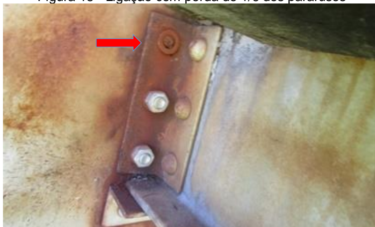
Figura 15 - Ligação com perda de 1/6 dos parafusos
