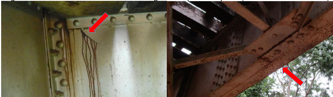
Figura 22 - Trinca na alma e na mesa do longarina de perfil composto (com redundância interna)
