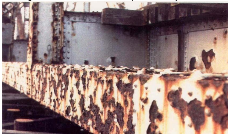
Figura 10 - Corda inferior com perda de seção efetiva
