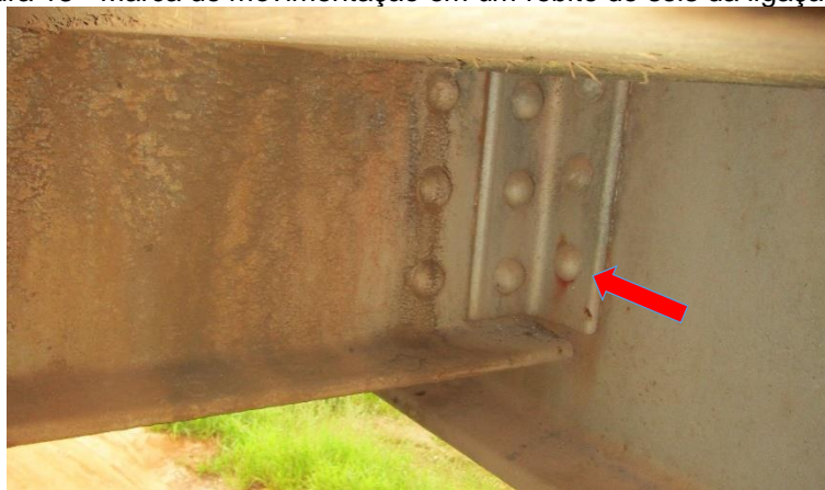
Figura 13 - Marca de movimentação em um rebite de seis da ligação
