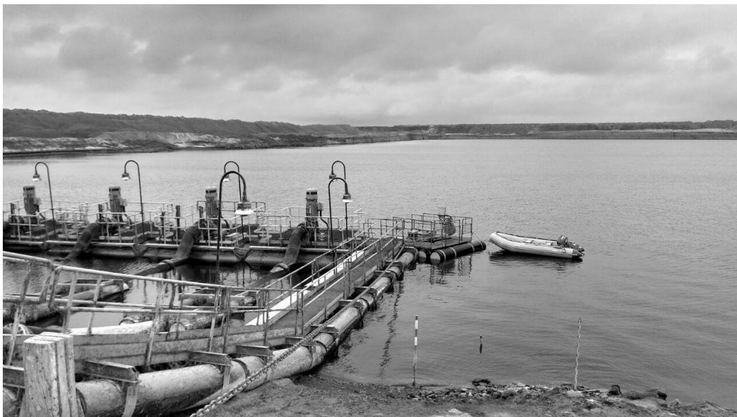
Figura 4.26 – Vista geral da estrutura disponível para os ensaios de campo
