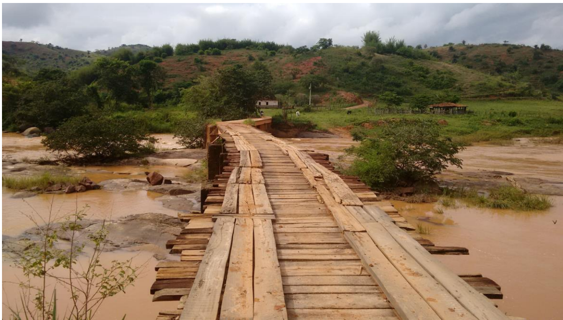
Figura 20 - Ponte sobre o rio Manhuaçu, novembro de 2016.
