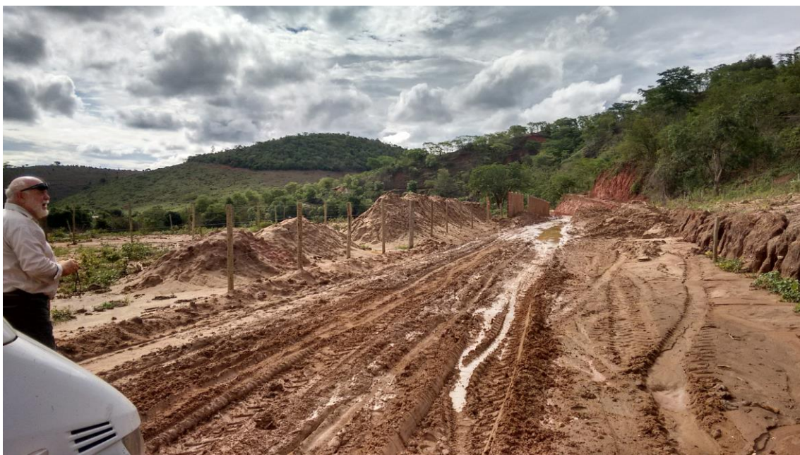
Figura 14 - Estrada de terra no período chuvoso, em novembro de 2016.
