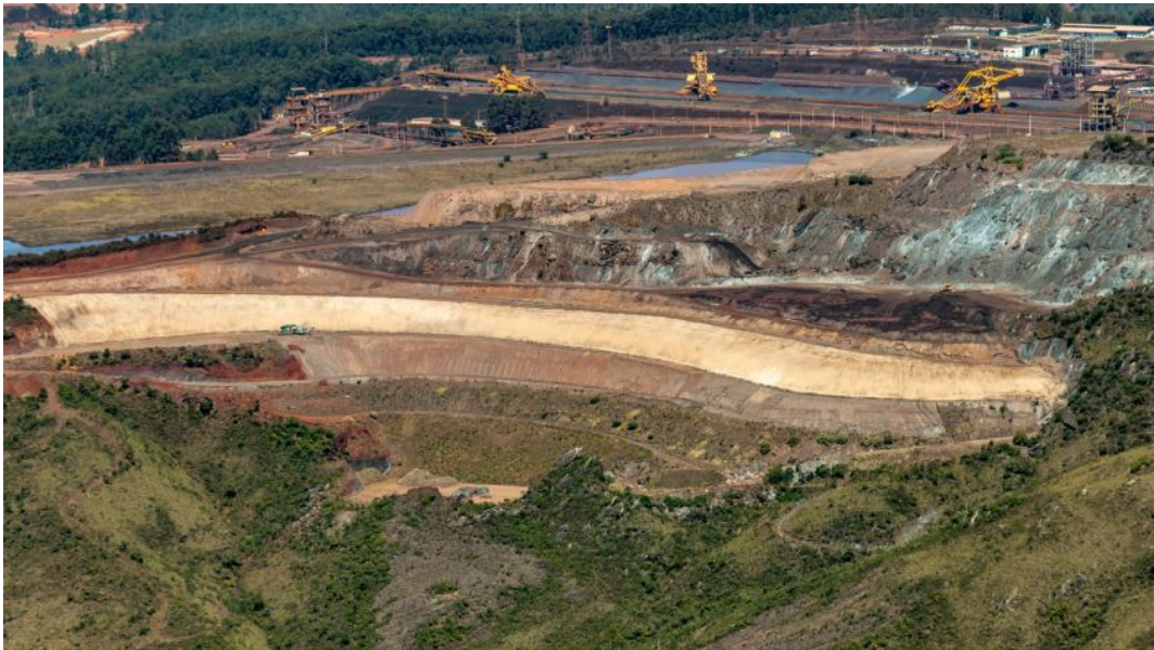
Figura 4.6 - Empilhamento de rejeitos de minério de ferro desaguado em baias. (Dados de relatório de projeto, VALE S.A)
