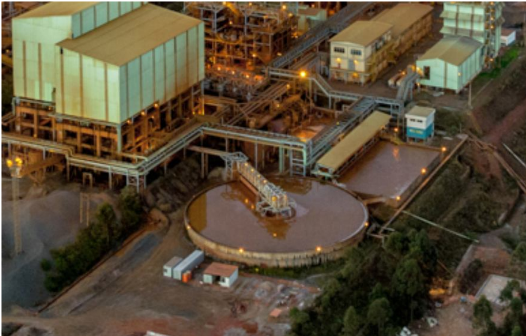
Figura 2.4 – Espessador convencional em operação na ITM-I. (Arquivo fotográfico, VALE S.A, 2016)
