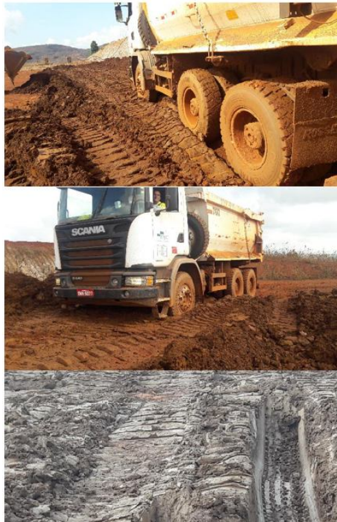
Figura 2.28 – Aterro formado com os rejeitos finos filtrados. (Dados de relatório de projeto, VALE S.A)
