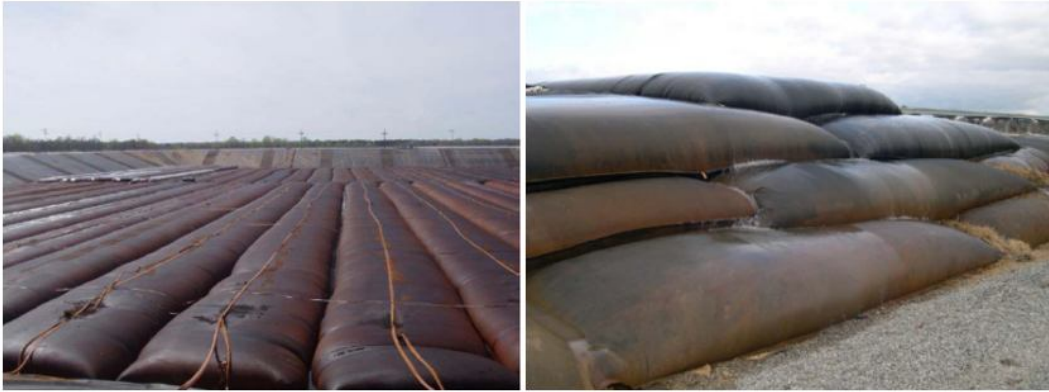
Figura 2.14 – Tubos formados com geotêxtil ( geoforma ) preenchidos com rejeito. (Notas de Aula, GOMES RC, 2016)
