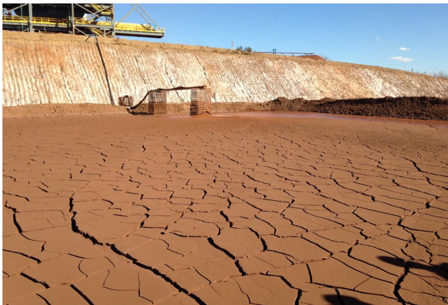
Figura 2.26 – Lama espessada, aterro formado em camadas. (Dados de relatório de projeto, VALE S.A)
