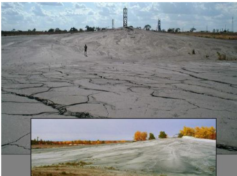
Figura 4.4 – Ilustra a formação do cone na disposição de rejeito espessado. (Notas de Aula, GOMES RC, 2016)
