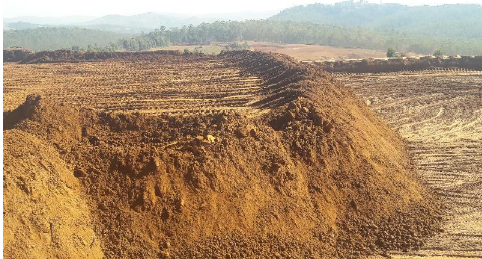
Figura 2.23 – Ilustra a formação do aterro em camadas. (Dados de relatório de projeto, VALE S.A)
