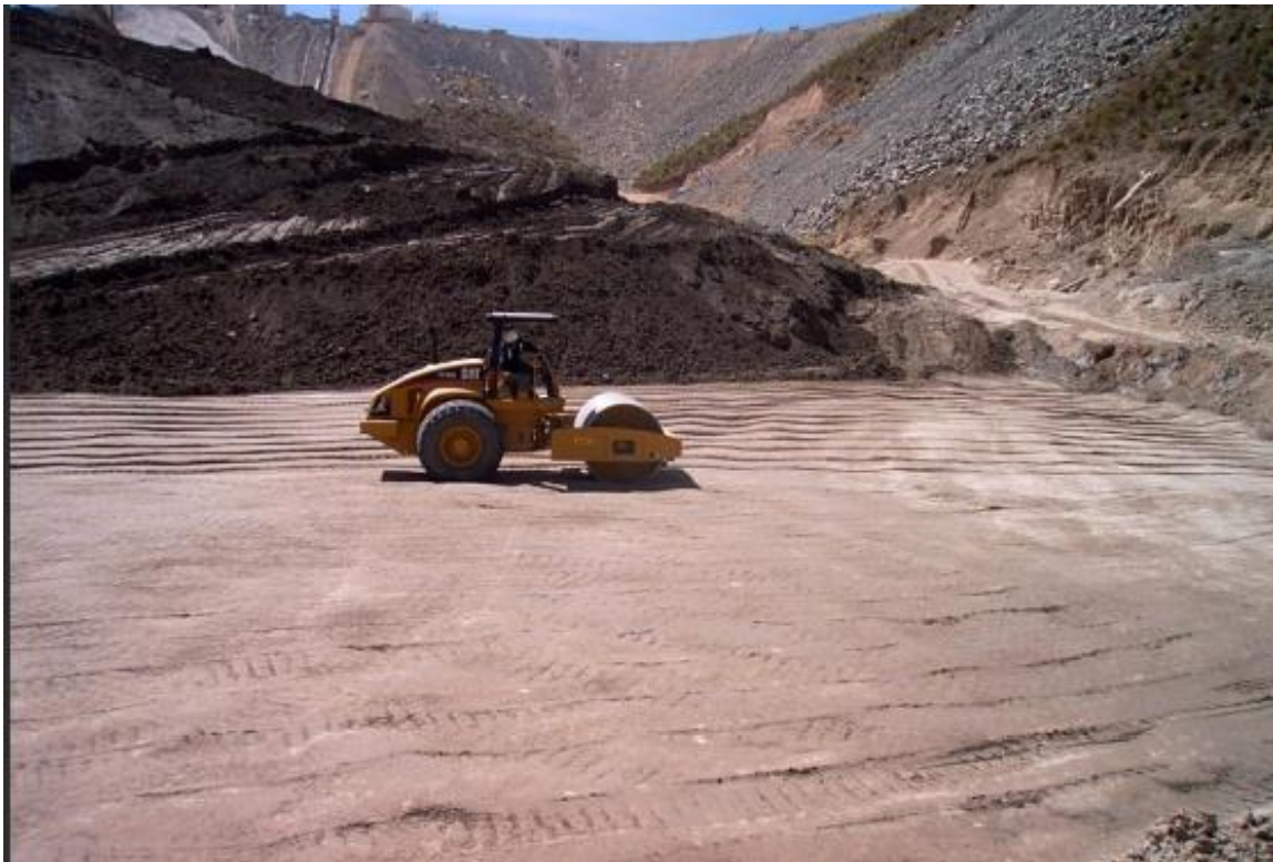
Figura 4.6 – Empilhamento drenado ( dry stacking ) de rejeitos na Mina Pau Branco. A planta de filtragem e peneiramento que possibilitou eliminar a necessidade de barragem, entrou em operação em novembro de 2015 (Gomes et al., 2016b)
