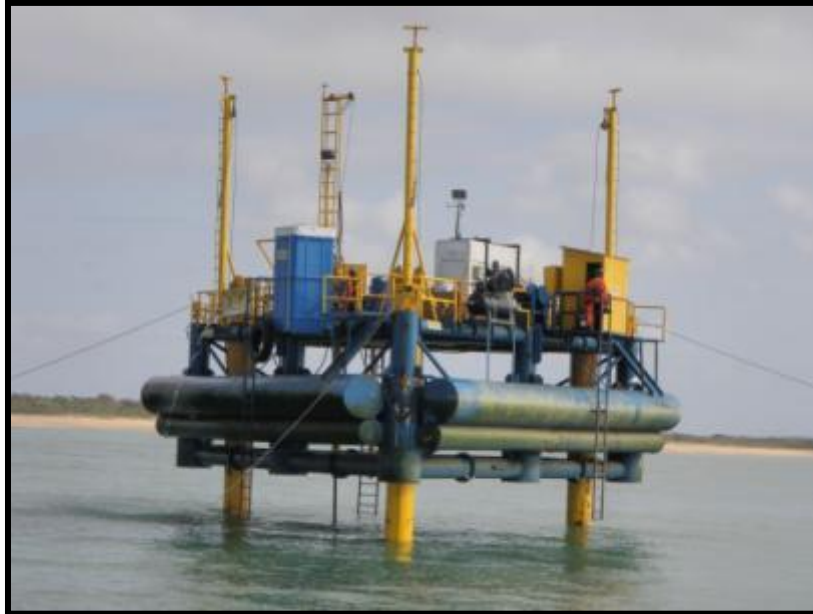
Figura 3.14 - Plataforma auto-elevatória utilizada para realização das sondagens (Umisan, 2011).
