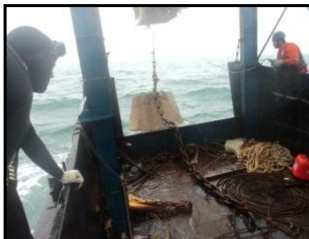
Figura 3.17 - Rebocador em operação de posicionamento das poitas utilizando guincho (Umisan, 2011).
