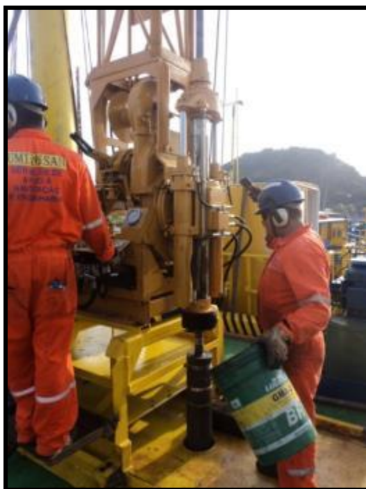
Figura 3.24 - Sondagem rotativa (Umisan, 2011).
