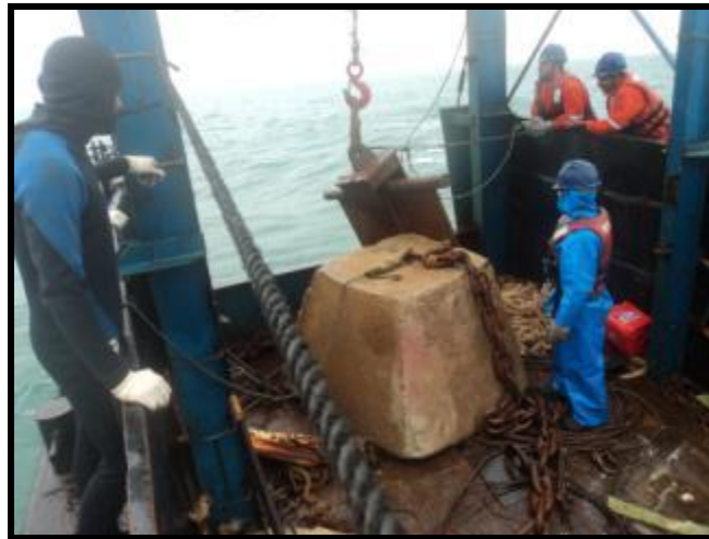
Figura 3.16 - Poitas utilizadas para fixação e estabilização da plataforma (Umisan, 2011).
