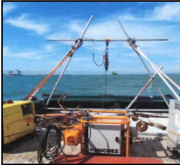
Figura 3.3 - Roldana de contagem instalada na estrutura em "A" (Dragabrás, 2011).
