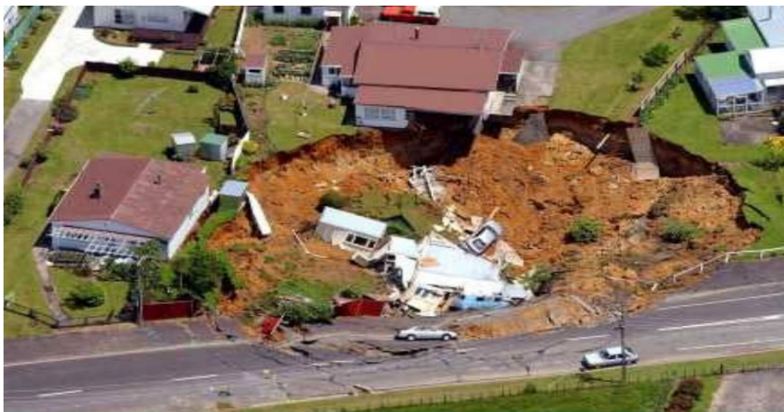
Figura 3.8 Subsidência: causada pelo rebaixamento do lençol freático em uma mina de ouro na Nova Zelândia. Fonte: http://www.google/Image – (Acesso em:12/12/2013).
