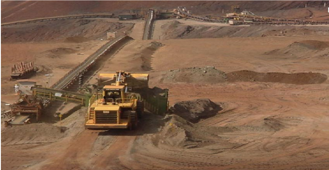
Figura 3.4 Aspecto de uma Praça de Lavra de Minério de Ferro em atividade. Fonte: Acervo SAMARCO.
