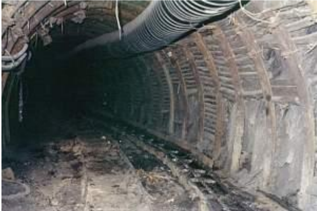
Figura 3.10 Detalhe de uma galeria de mina subterrânea.
