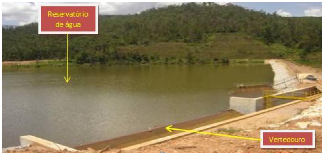
Figura 3.14 Barragem de tratamento/recuperação de água de processo.
