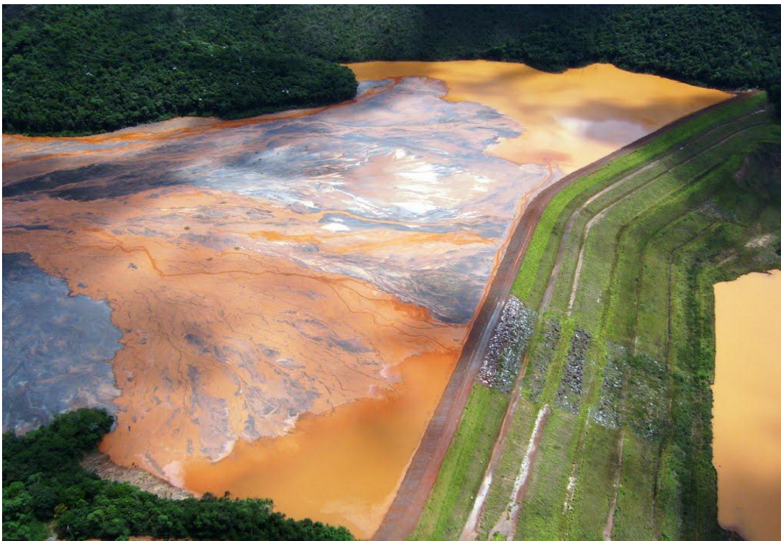
Figura 3.12 Depósito de rejeitos dos processos de beneficiamento de minério.
