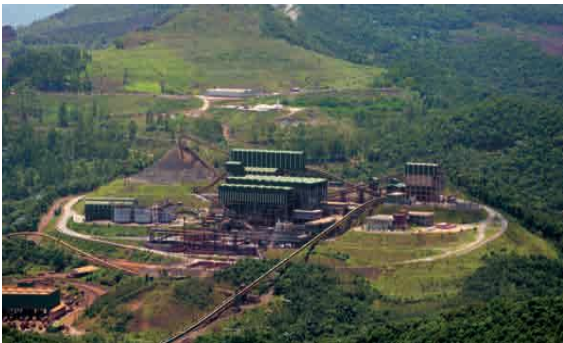
Figura 3.22 Vista Geral da Usina de Concentração 2, de Germano.
