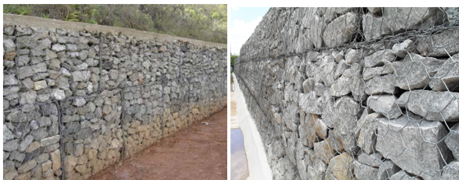
Figura 3.9 – Uso de Escória de LD na formação de Gabiões de contenção. Fonte: www.geobrasil.com.br (2005).
