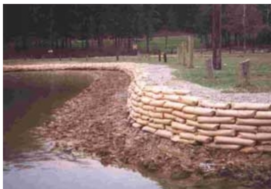
Figura 3.10 –Utilização de escória de LD granulada em Rip-rap's de contenção. Fonte: www.geobrasil.com.br (2005).
