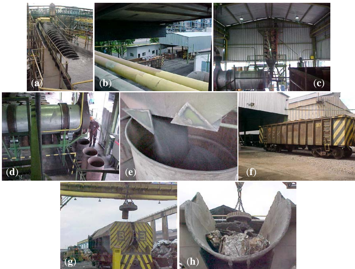
Figura 4.25 – Planta Industrial, capacidade: 3.000 t/mês, instalada na CSN e operada pela K&K: (a) classificador parafuso retirando a lama grossa do espessador; (b) tubulação por onde a lama é bombeada para a planta de tratamento pelo D.U.S.; (c) planta de tratamento da lama de aciaria pelo processo D.U.S.; (d) forno de secagem onde o material é descarregado em tambores; (e) concentrado seco carregado em tambores; (f) vagão levando os tambores com o concentrado para alimentação na aciaria; (g) eletroímã carregando o tambor contendo o concentrado metálico na caixa de sucatas; (h) vista de frente da caixa de sucatas.
