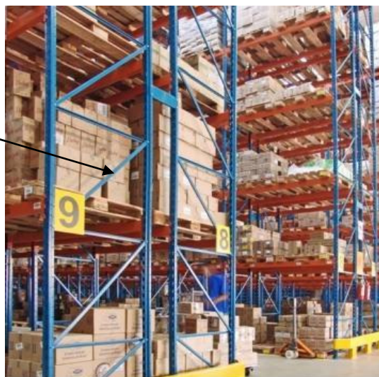
FIGURA 2.13 - Contraventamentos laterais do sistema porta-pallets (ÁGUIA, 2011).
