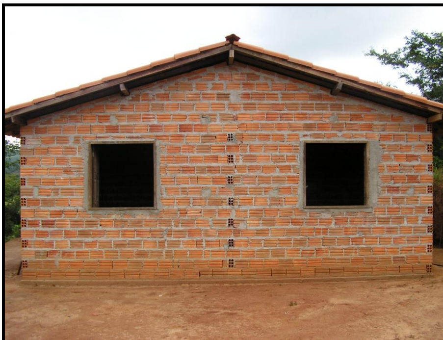
Figura 4 – Unidade Domiciliar com um padrão de construção tipo B. Localidade Barra do Palmital – Berilo, MG.
