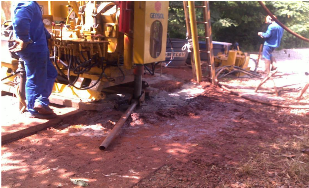
Figura 1.4 – Equipamento de Sondagem (Perfuratriz)
