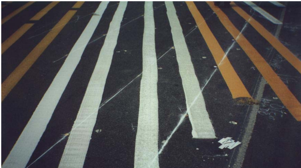
FIGURA 3.6. - Pré - marcação das trilhas de rodas interna e externa
