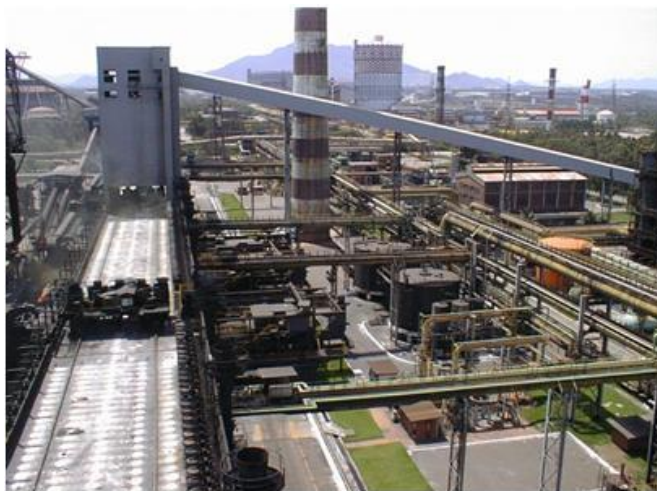
Figura 7 . Vista superior das baterias convencionais da ArcelorMittal Tubarão.
