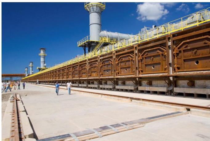
Figura 8 . Vista lateral das baterias de fornos tipo colméia ( heat recovery )
