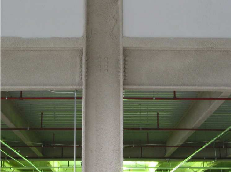
Figura 4.4 – Argamassa projetada (COSTA, 2001)
