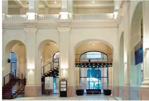
Figura 2.12 - Escada e passarela em aço e madeira, de acesso ao mezanino. Fonte: ZEIN, Ruth Verde; DI MARCO, Anita Regina, 2001.p.207.
