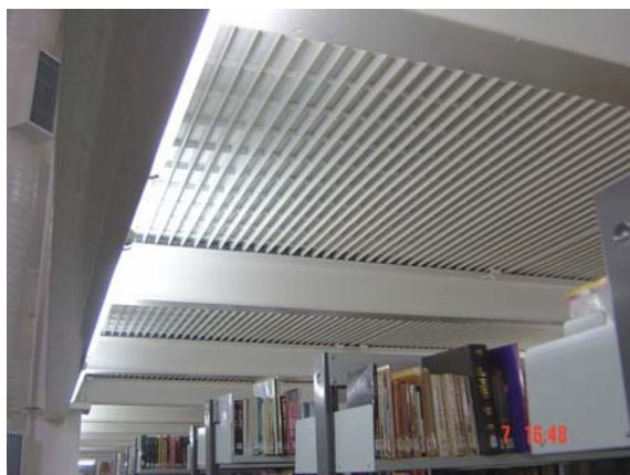
Figura 6.62 – Detalhes. a) Grelha metálica do piso vista de baixo b) Piso emborrachado. Fonte: Arquivo particular do autor, junho, 2006.
