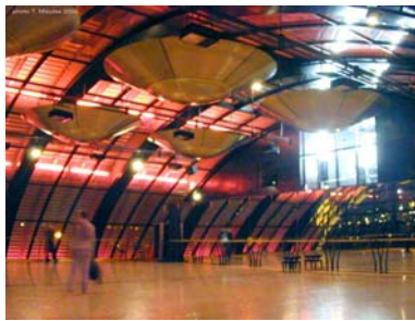
Figura 2.16 - Cobertura metálica. Fonte: ECOLE ATHENAEUM. Ópera de Lyon . [S.l.], fevereiro de 2002.
