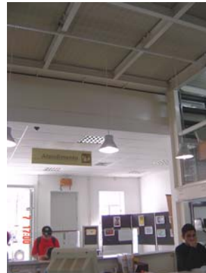
Figura 6.81 a e b – Vigas de mesma seção nos vigamentos principais transversais e internos nos pisos (tetos) das galerias. Fonte: Arquivo particular do autor, julho de 2006.
