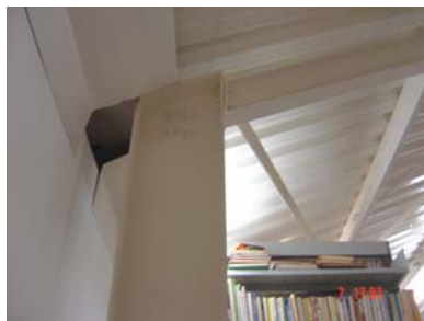
Figura 6.76 a e b – Detalhe afastamento da nova estrutura em aço das paredes antigas. Fonte: Arquivo particular do autor, julho de 2006.
