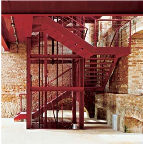
Figura 6.28 - Vista lateral da escada. Fonte: SERAPIÃO, Fernando, abril de 2005.
