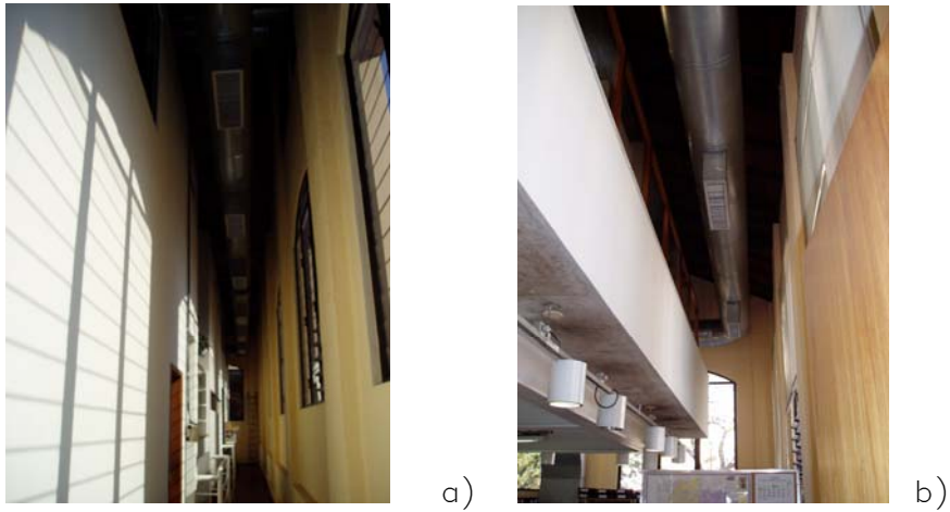
Figura 6.94 a e b – Recuo da estrutura nova das paredes da edificação antiga. Fonte: Arquivo particular do autor, julho de 2006.
