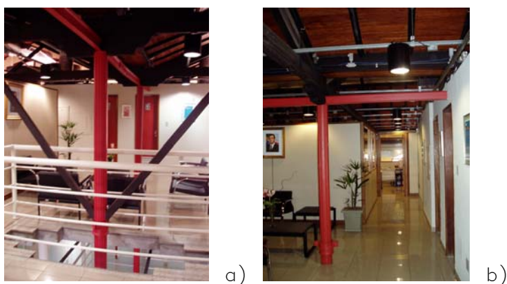
Figura 6.107 a e b – Pilares em ferro fundido existentes. Fonte: Arquivo particular do autor, julho de 2006.
