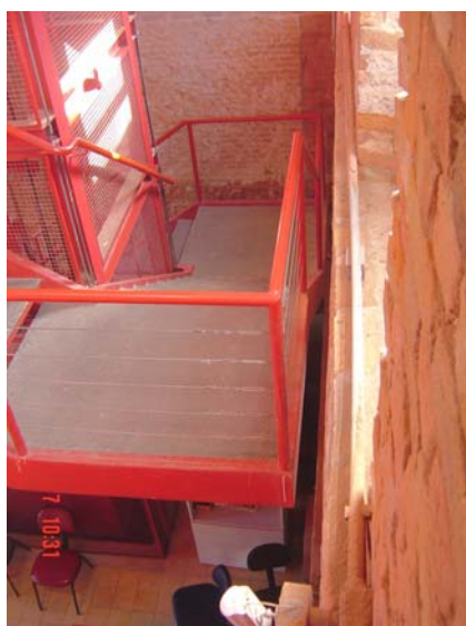
Figura 6.27 - Vista superior da escada. Fonte: Arquivo particular do autor, julho de 2006.
