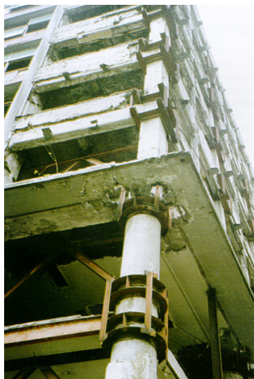
Figura 4.2 - Reforço com instalação de contraventamento para resistência sísmica. Fonte: CALADO, 1997, p.20-25.
