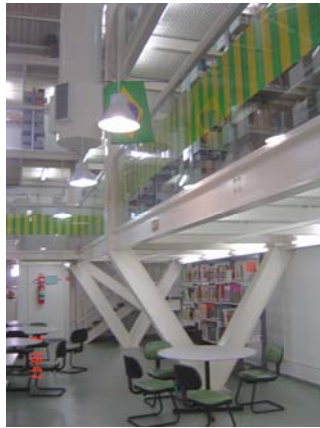
Figura 6.74 - Detalhe estrutura- transição de pilares no pavimento térreo. Fonte: Arquivo particular do autor, julho de 2006.
