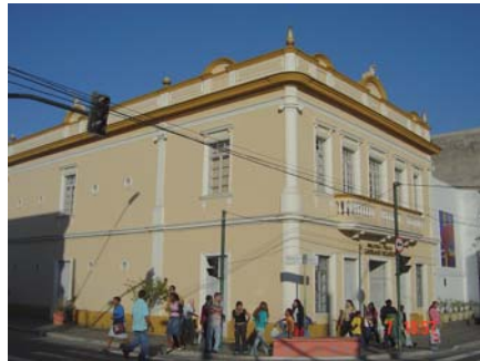
Figura 6.72 - Foto externa - edifício restaurado. Fonte: Arquivo particular do autor, julho de 2006.
