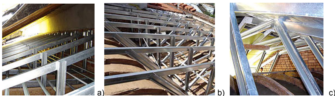
Figura 4.15 – Estrutura nova. a) Detalhe 01. b) Detalhe 02. c) Detalhe 03. Fonte: ACBM, 2006.
