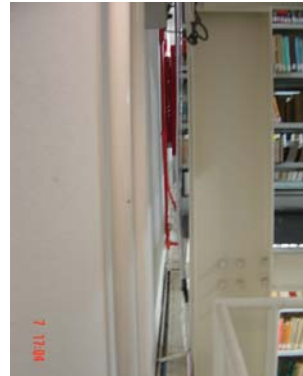
Figura 6.75 a e b Detalhe afastamento da nova estrutura em aço das paredes antigas. Fonte: Arquivo particular do autor, julho de 2006.
