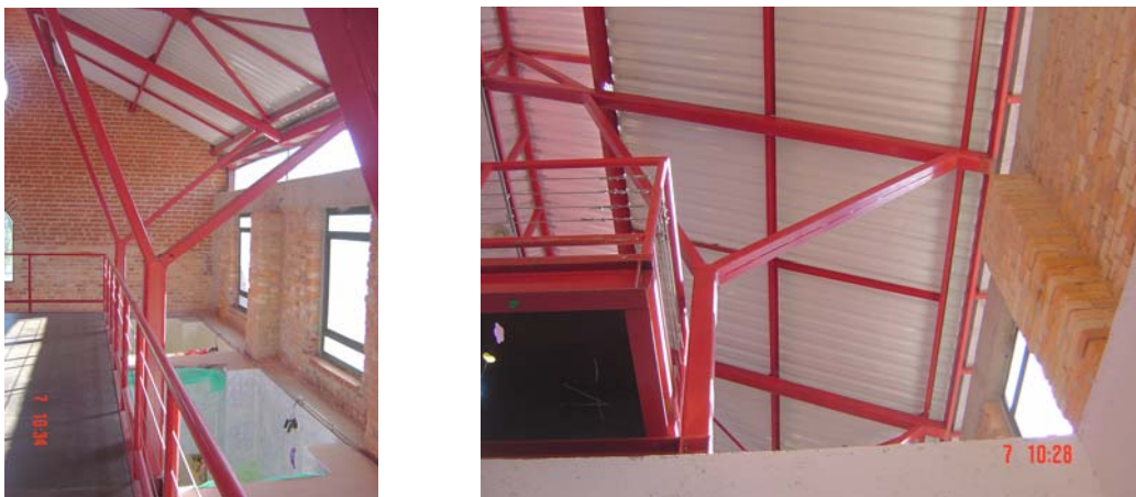
Figura 6.31 – Detalhe estrutura do mezanino e cobertura. Fonte:Arquivo particular do autor, julho de 2006.
