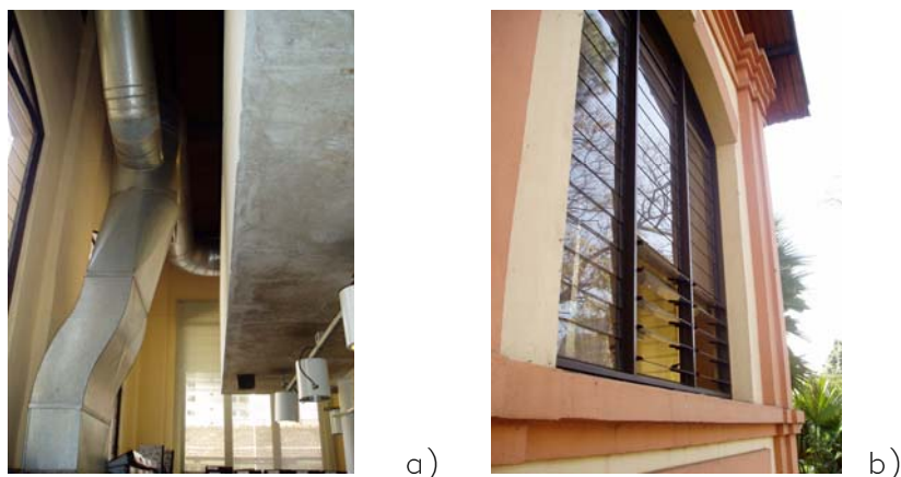
Figura 6.101 – Dutos do ar condicionado e detalhe dos basculantes. Fonte: Arquivo particular do autor, julho de 2006.
