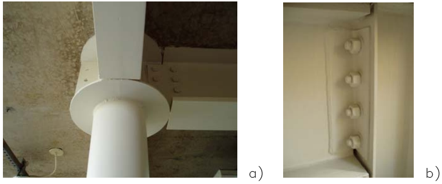
Figura 6.111 a e b – Ligações parafusadas Fonte: Arquivo particular do autor, julho de 2006.
