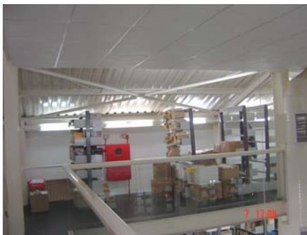
Figura 6.77 – Contraventamento na cobertura. Fonte: Arquivo particular do autor, julho de 2006.
