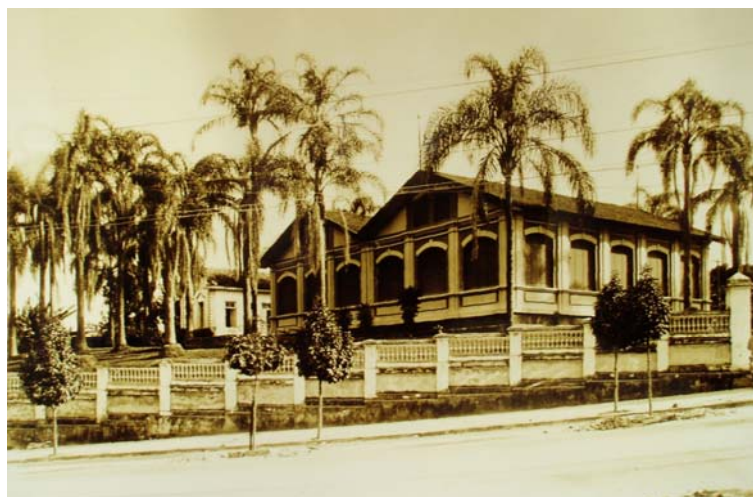
Figura 6.85 – Exterior do edifício antigo.
