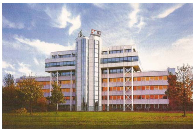
Figura 4.12 – Edifício de escritórios, Amsterdã, Holanda. Fonte: INTERNATIONAL IRON AND STEEL INSTITUTE, 1993, p.27.
