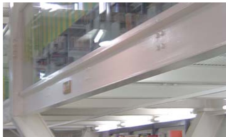
Figura 6.84 – Ligações parafusadas viga x viga. Fonte: Arquivo particular do autor, julho de 2006.
