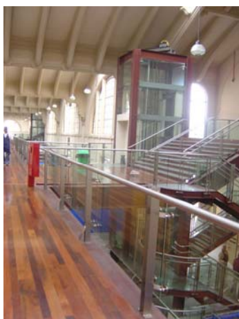
Figura 6.42 – Guarda Corpo em aço e vidro. Fonte: Arquivo particular do autor, fev. 2004.
