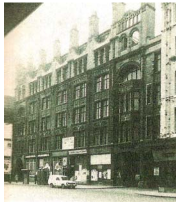
Figura 4.20 – Edifício em estado original. Fonte: INTERNATIONAL IRON AND STEEL INSTITUTE, 1993, P.37.
