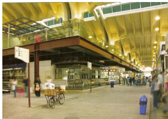
Figura 6.40 – Intervenção realizada no Mercado Municipal, a estrutura metálica x ambiente antigo. Fonte: FIGUEROLA, 2004, p.45.
