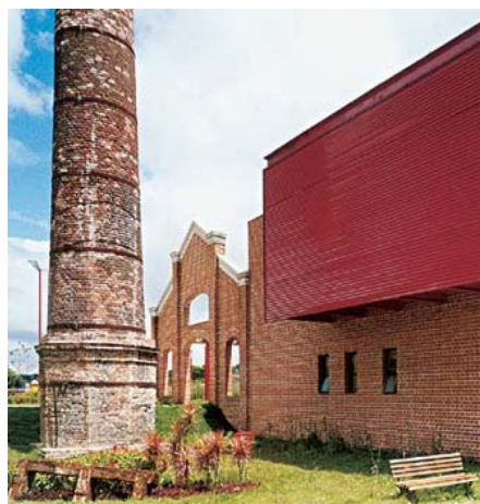
Figura 6.33 – Chaminé recomposta- anéis metálicos para reforço dispostos ao longo de sua altura. Fonte: SERAPIÃO, Fernando, abril de 2005.
