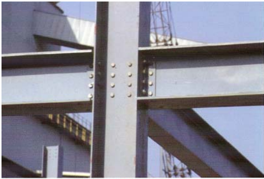
Figura 3.9 a e 3.9 b – Conexões flexíveis. Fonte: DIAS, Luis Andrade, 2002, p.103.
