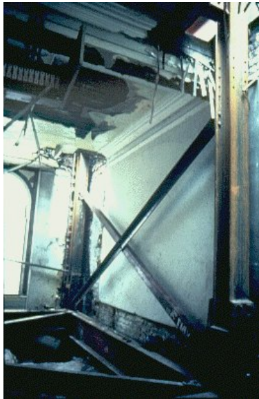
Figura 4.6 - Instalação de estrutura antes da demolição dos pisos e parede internas. Fonte: KATHOOLIEKE UNIVERSITET LEUVEN, [200-?].
