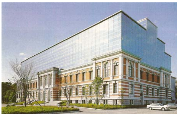
Figura 4.16 - Edifício administrativo, Kobe, Japão. Fonte: INTERNATIONAL IRON AND STEEL INSTITUTE, 1993, p.24.
