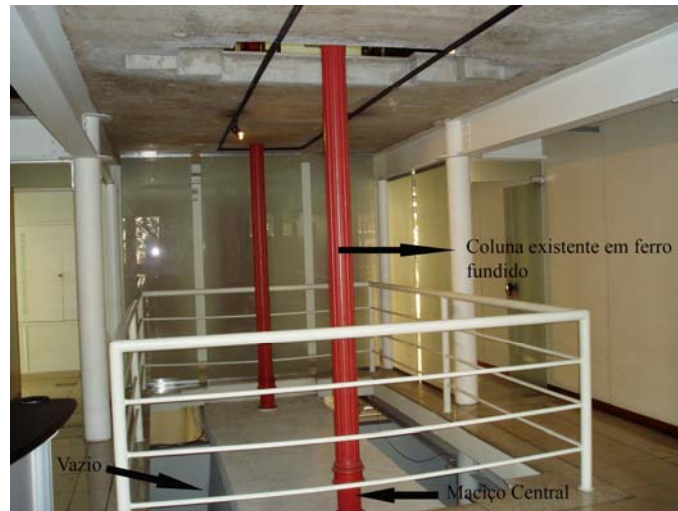
Figura 6.96 – Vazia do primeiro pavimento (detalhe do maço central). Fonte: Arquivo particular do autor, julho de 2006.
