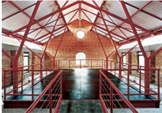
Figura 6.32 - Detalhe estrutura do mezanino e cobertura. Fonte: SERAPIÃO, Fernando, abril de 2005.
