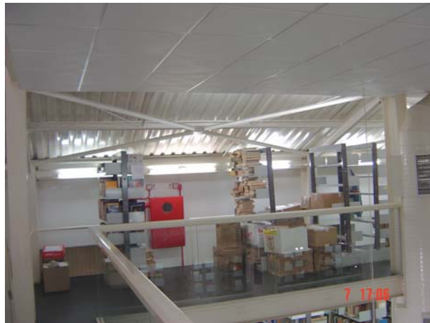
Figura 6.60 – Detalhe do guarda corpo em vidro. Fonte: Arquivo particular do autor, julho de 2006.
