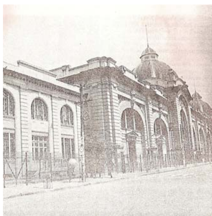
Figura 6.46 – Foto do Mercado e um de seus anexos que foram demolidos. Fonte: SABBAG, dez 88 / jan 89, p.46.
