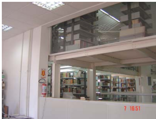
Figura 6.81 a e b – Vigas de mesma seção nos vigamentos principais transversais e internos nos pisos (tetos) das galerias. Fonte: Arquivo particular do autor, julho de 2006.
