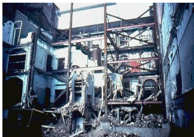
Figura 4.4- Demolição de estrutura interna e instalação parcial de nova estrutura de aço. Fonte: KATHOOLIEKE UNIVERSITET LEUVEN. [200-?].
