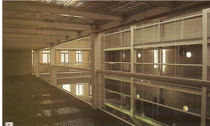
Figura 6.61 – Detalhe da grelha metálica antes da colocação do piso emborrachado. Fonte: PROJETO, 1998, p.49.
