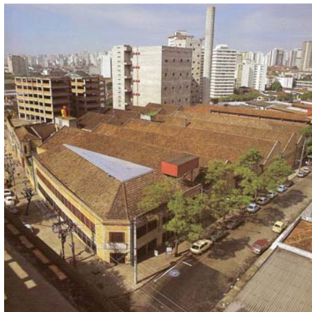
Figura 2.1 – Edifício antigo e anexo construído. Fonte: BO BARDI, Lina , 1996. [Não paginado].
