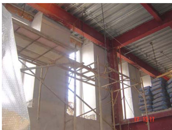
Figura 1.3- Construção do Novo Centro de Informações Turísticas- Estrutura em aço por trás da fachada. Fonte: Foto do autor
