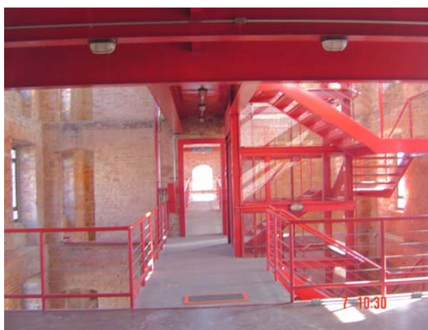
Figura 6.25 - Vista do mezanino do primeiro pavimento. Fonte: Arquivo particular do autor, julho de 2006.
