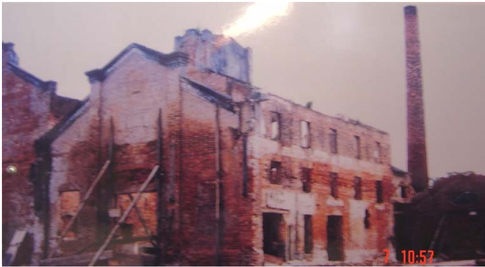
Figura 6.9 – Galpão 2- original do conjunto.
