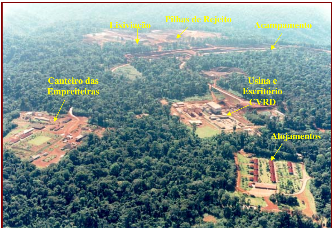
Foto 2 - Vista Geral das instalações da mina de ouro Igarapé Bahia (foto cedida CVRD).
