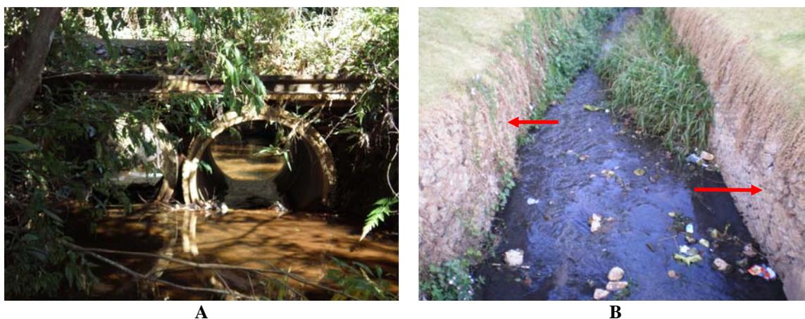
**Figura 4.9** - Diferentes alterações no canal de 2 trechos de rios. Em (A) observa-se uma situação encontrada no interior do Parque Estadual do Itacolomi, Ouro Preto - MG – nota-se a presença de manilha para vazão sob a estrada. Em (B) observa-se a retificação de um curso d'água na zona urbana de Ouro Preto - MG, onde nota-se a presença de gabiões nas laterais das margens (indicados pelas setas).
