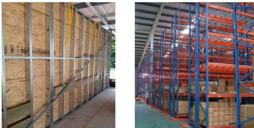
Figura 6: Perfis formados a frio com perfurações empregados. À esquerda no Sistema Light Steel Framing e à direita em sistema de armazenagem industrial. Fonte: autor.
