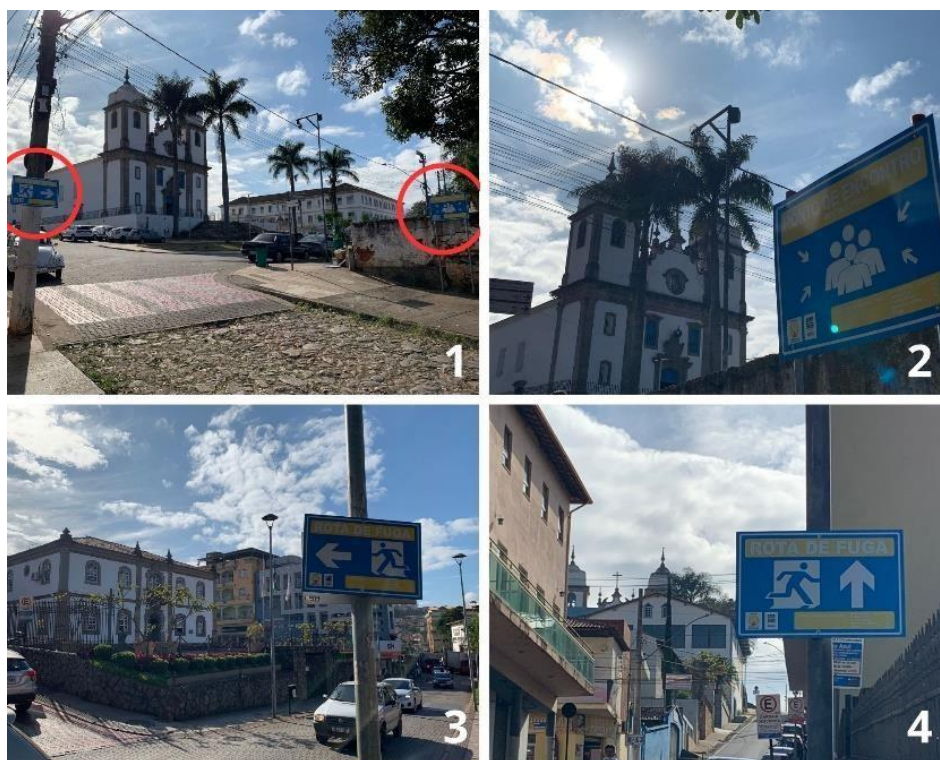
Figura: 10 - Placas de sinalização de 'Rota de Fuga' em toda a cidade. Parte 3
