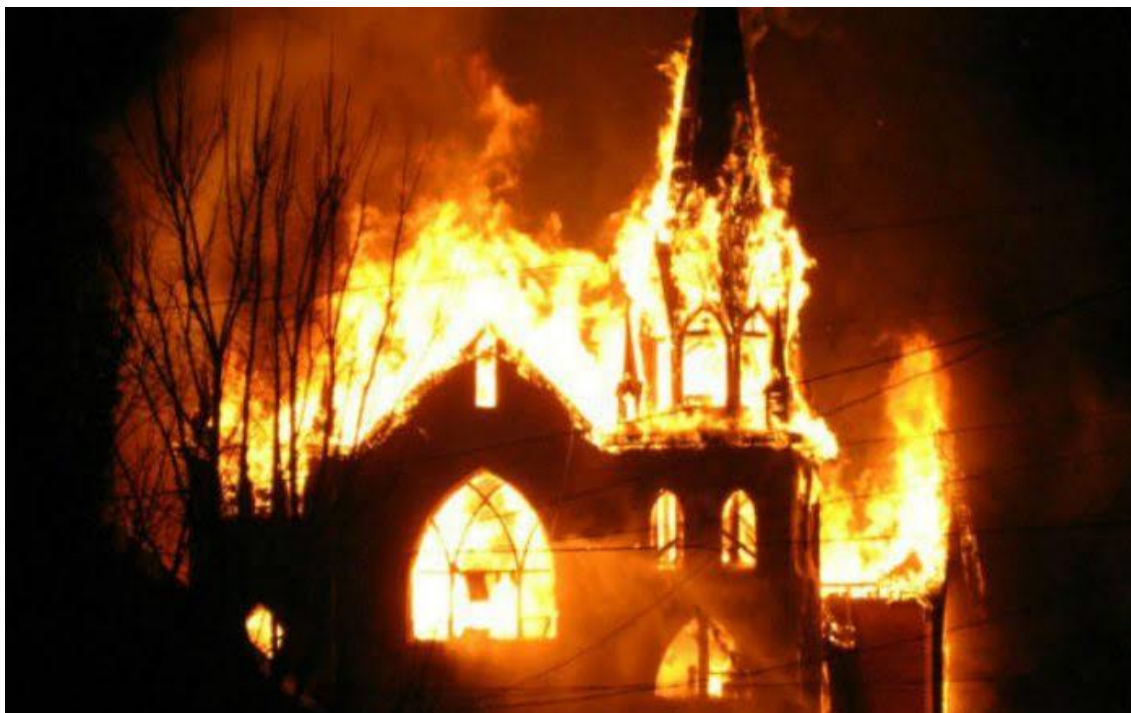
Figura 31: Templo católico incendiado no Canadá. Imagem sem autoria. Retirada do jornal Boca da Mata
