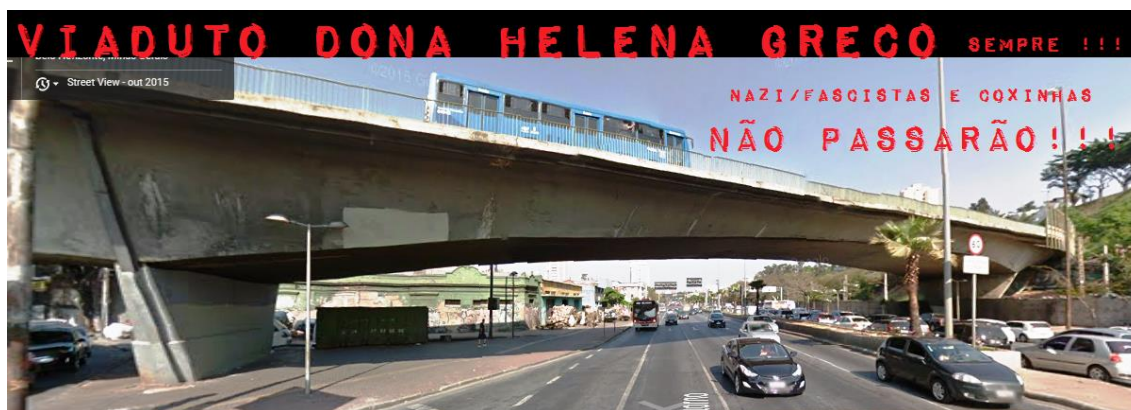
Figura 24: Viaduto D. Helena Greco. Imagem sem autoria. Retirada do blog do IHG.
