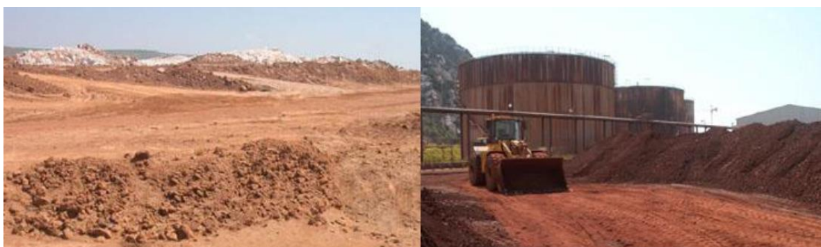
Figura 2.6 – Pilhas de rejeito de bauxita filtrado (Tessarotto, 2015)
