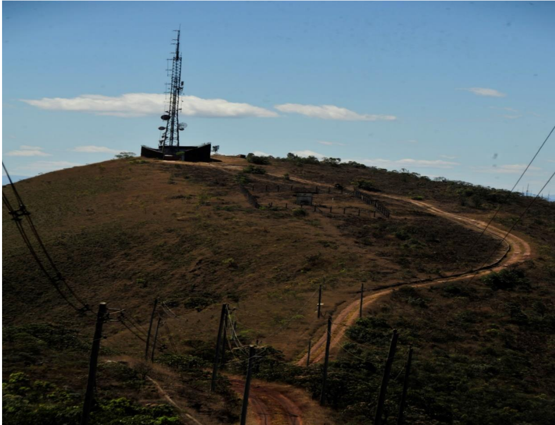
Figura 2 – Estruturas de telecomunicações no Morro do Cachimbo – PESRM / BH / MG
