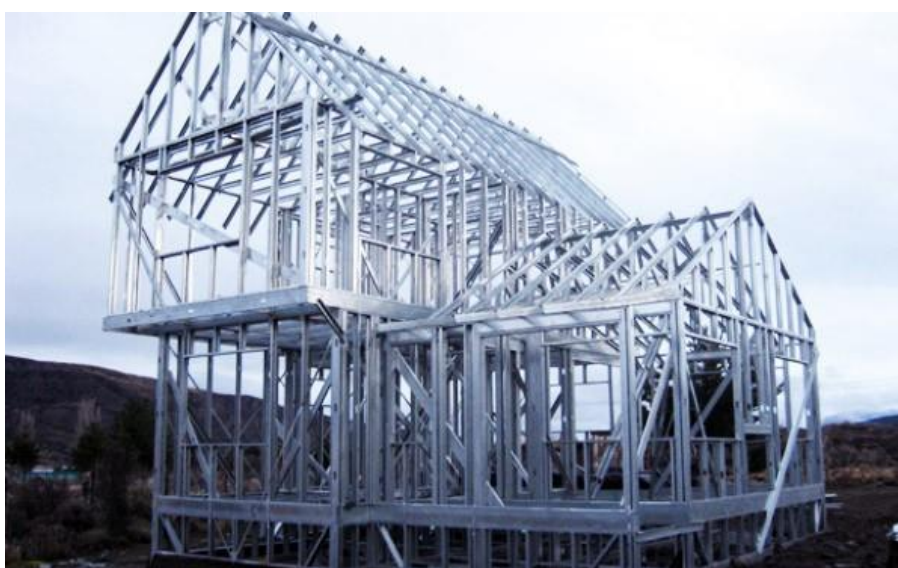
Figura 1 - Esqueleto de uma obra em Sistema de Construção em LSF
