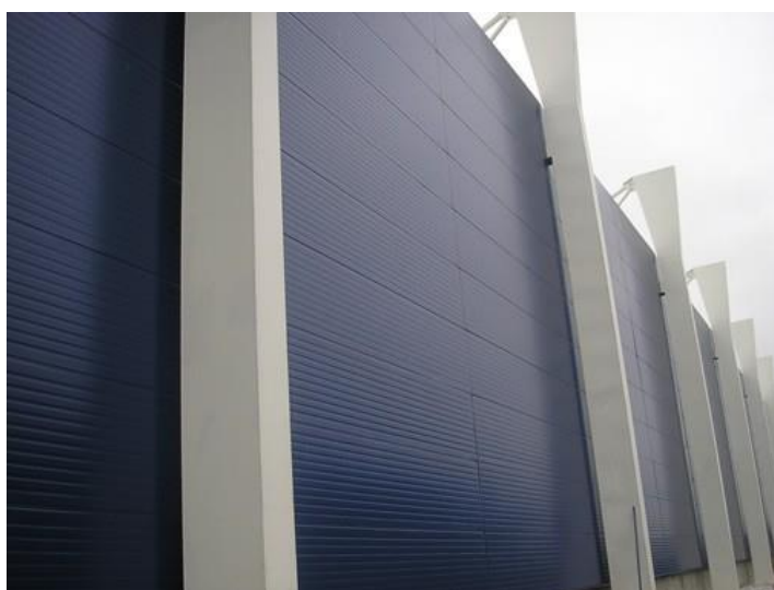
Figura 12 - Telhas metálicas utilizadas como painel de fechamento(2) Fonte: SILVA, 2016
