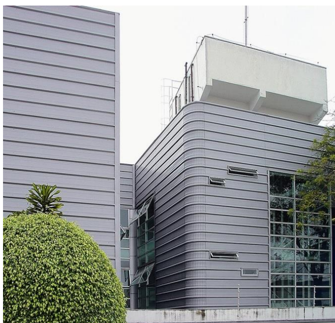
Figura 11 - Telhas metálicas utilizadas como painel de fechamento(1) Fonte: SILVA, 2016
