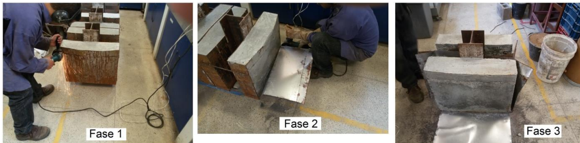
Figura 77: Desmontagem das fôrmas nas três fases subsequentes
