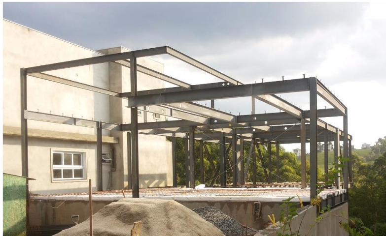
Figura 23: Conector tipo “T em chapa” aplicado na estrutura metálica
