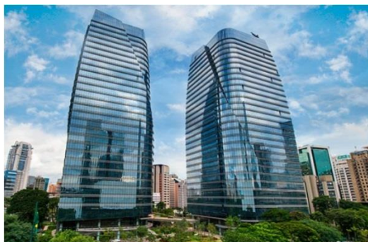
Figura B16: Edifício Viol obra concluída, no ano 2015
