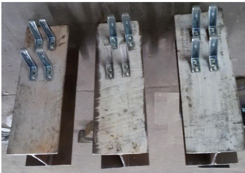
Figura 44: Conectores Hilti X-HVB fixados no perfil laminado
