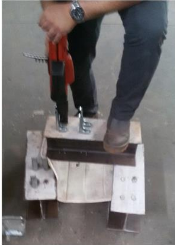
Figura 43: Fixação dos conectores Hilti X-HVB
