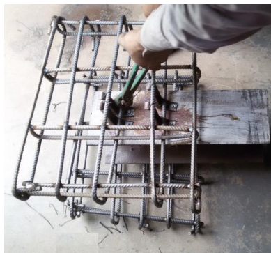
Figura 55: Armadura com os conectores em fase de amarração
