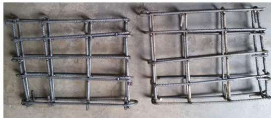
Figura 54: Armadura para amarração dos conectores
