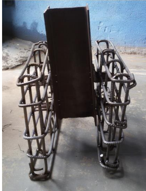
Figura 56: Armadura com os conectores completamente amarrados
