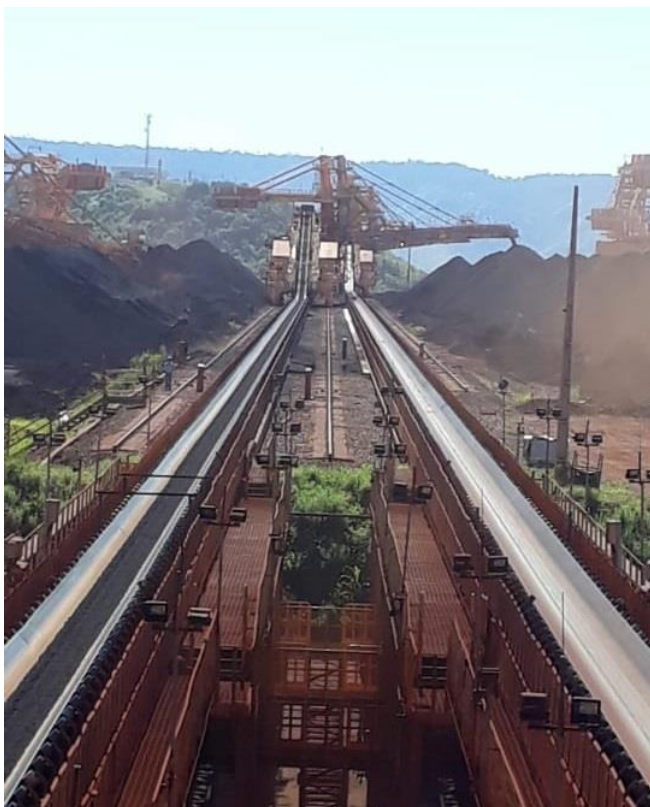
Figura 20: Empilhadeira EP-2091KS-03 em S11D
