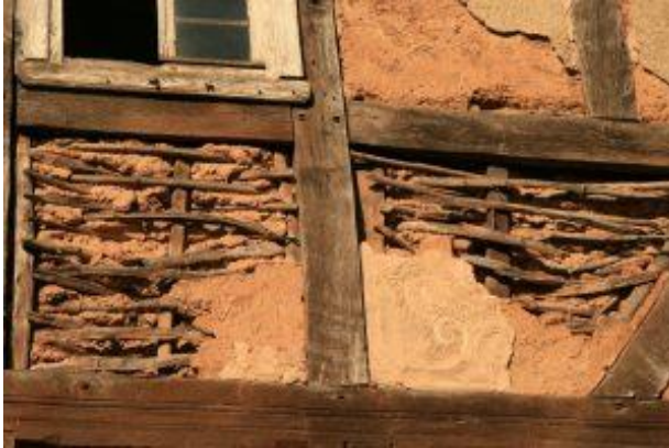
Figura 3-29: Parede em wattle-and-daub . Fonte: https://www.geefix.com/wattle-and-daub . Acesso em 01 de dez. 2020.
