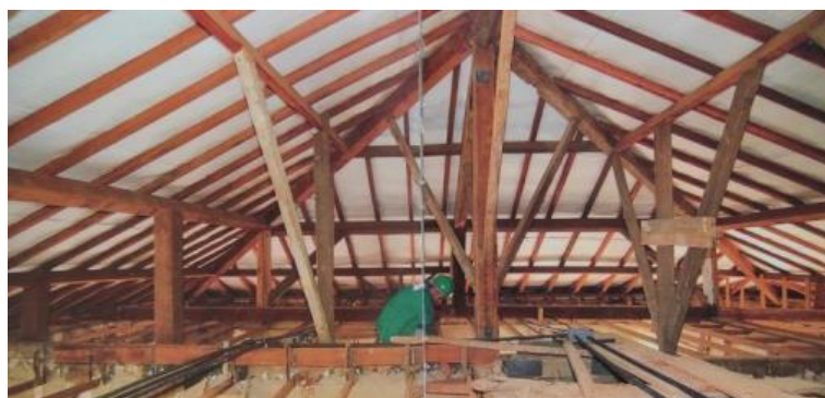
Figura 3-14: Estrutura do telhado em madeira da Casa Bernardo Guimarães. Fonte: FAOP, 2008, p.32 e 33.
