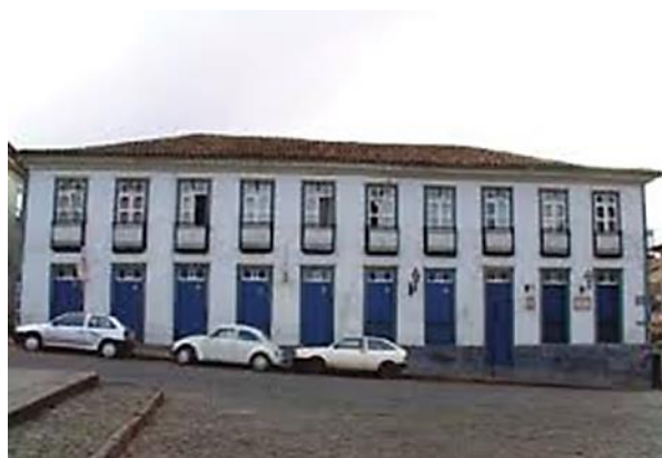
Figura 1-3: Hotel Pilão antes do incêndio. Fonte: Rodrigo Marcandier.
