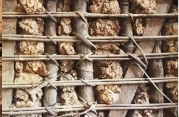
Figura 3-30: Trecho de parede em pau a pique. Fonte: arquivo pessoal.
