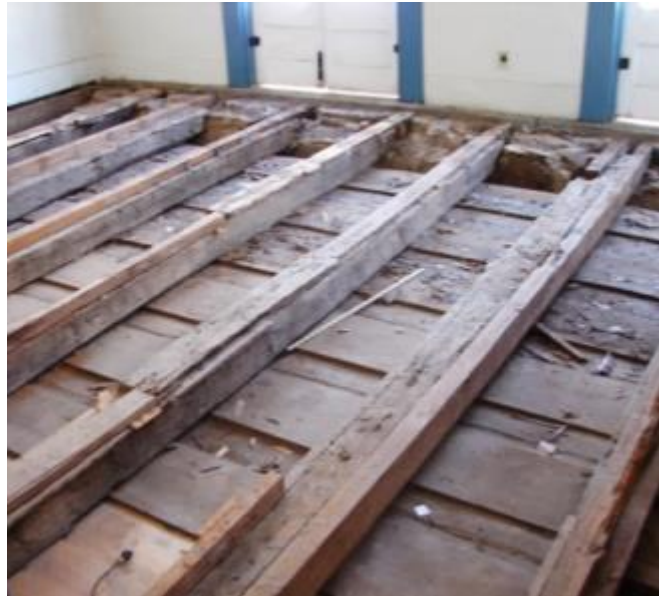
Figura 3-11: Barrotes de sustentação do piso do segundo pavimento do edifício da FAOP, no Bairro Rosário, OP. Fonte: arquivo pessoal.
