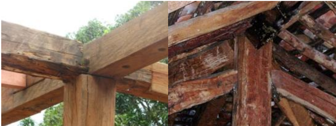
Figura 3-31: Encaixes comuns das peças estruturais em madeira, encontrados na arquitetura colonial na região de Ouro Preto. Fonte: arquivo pessoal.
