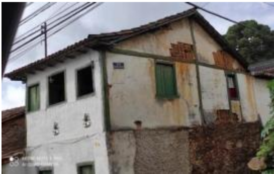
Figura 3-33: Casa em pau a pique, com parede em estado ruim de conservação, em Ouro Preto, MG. Fonte: arquivo pessoal.
