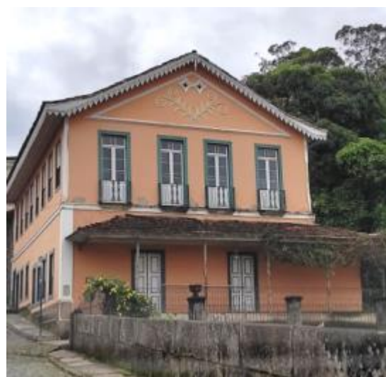
Figura 3-15: Esquadrias de portas e janelas em madeira e beiral com lambrequim em madeira. Fonte: arquivo pessoal.
