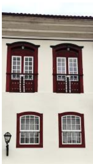
Figura 3-17: Portas e janelas em madeira e beiral em cimalha. Fonte: arquivo pessoal.
