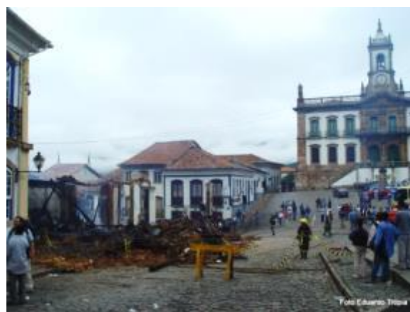
Figura 1-4: Hotel Pilão após o incêndio. Fonte: Eduardo Trópia. Disponível em: https://www.kickante.com.br/campanhas/desfile-de-moda-incendio-hotel-pilao-mg . Acessado em 12 de novembro de 2020.
