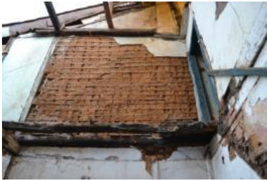
Figura 3-10: Trecho de parede com sistema construtivo em pau a pique à mostra. Foto: Ney Nolasco, 2008.
