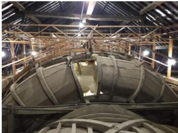
Figura 3-27: Estrutura em madeira do forro da capela-mor e estrutura metálica de reforço da estrutura original. Fonte: arquivo pessoal.
