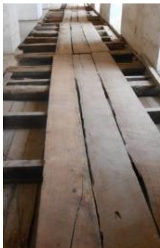
Figura 3-22: Piso em tabuado de madeira da tribuna. Fonte: arquivo
