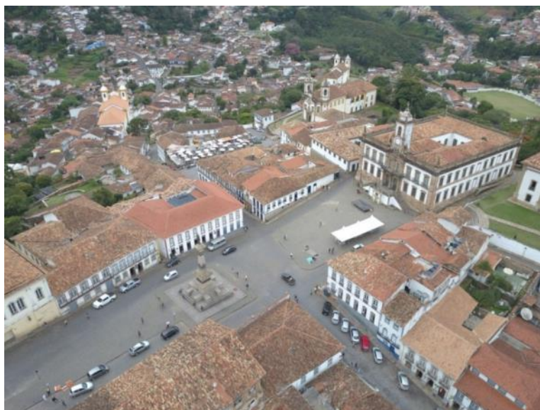
Figura 3-34: Vista aérea de Ouro Preto, da região da Praça Tiradentes. É possível perceber o conjunto de edificações geminadas, formando um único compartimento, e vias estreitas. Fonte: Próxima Trip. Disponível em: www.proximatrip.com.br , acessado em 04 nov. 2020.
