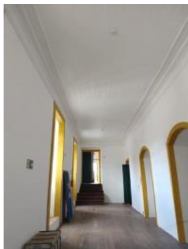
Figura 3-23: Corredor lateral, piso e forro em madeira. Fonte: arquivo pessoal.
