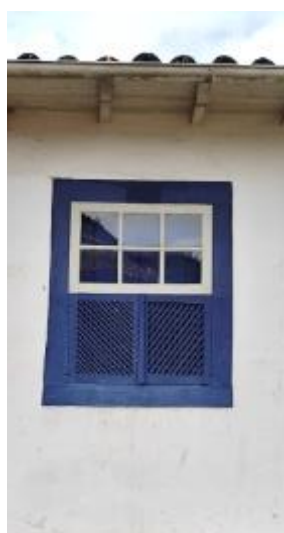
Figura 3-16 Esquadria de janela em madeira e detalhe do beiral em cachorro e guarda-pó em madeira. Fonte: arquivo pessoal.
