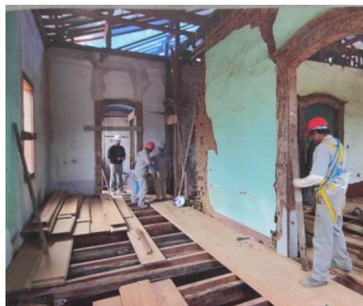
Figura 3-7: Estrutura em gaiola de madeira da Casa Bernardo Guimarães, FAOP. Fonte: FAOP, 2008, p.41.
