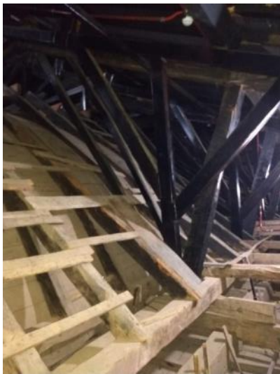
Figura 3-26: Estrutura em madeira do forro da nave e estrutura metálica de reforço. Fonte: arquivo pessoal.
