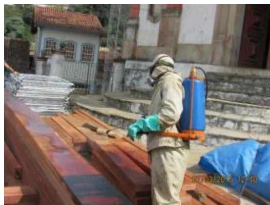
Figura 3-46: Trabalho de imunização por aspersão das madeiras novas que substituíram as madeiras danificadas. Foto: CONTRUTUTORA AMBIENTAL, 2015.
