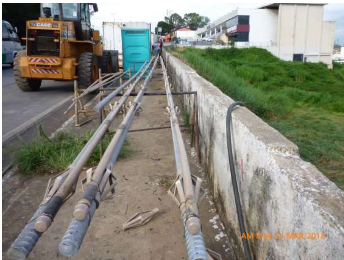
Figura 2-3 - Tirantes da estrutura sendo montados (DEER, 2018).
