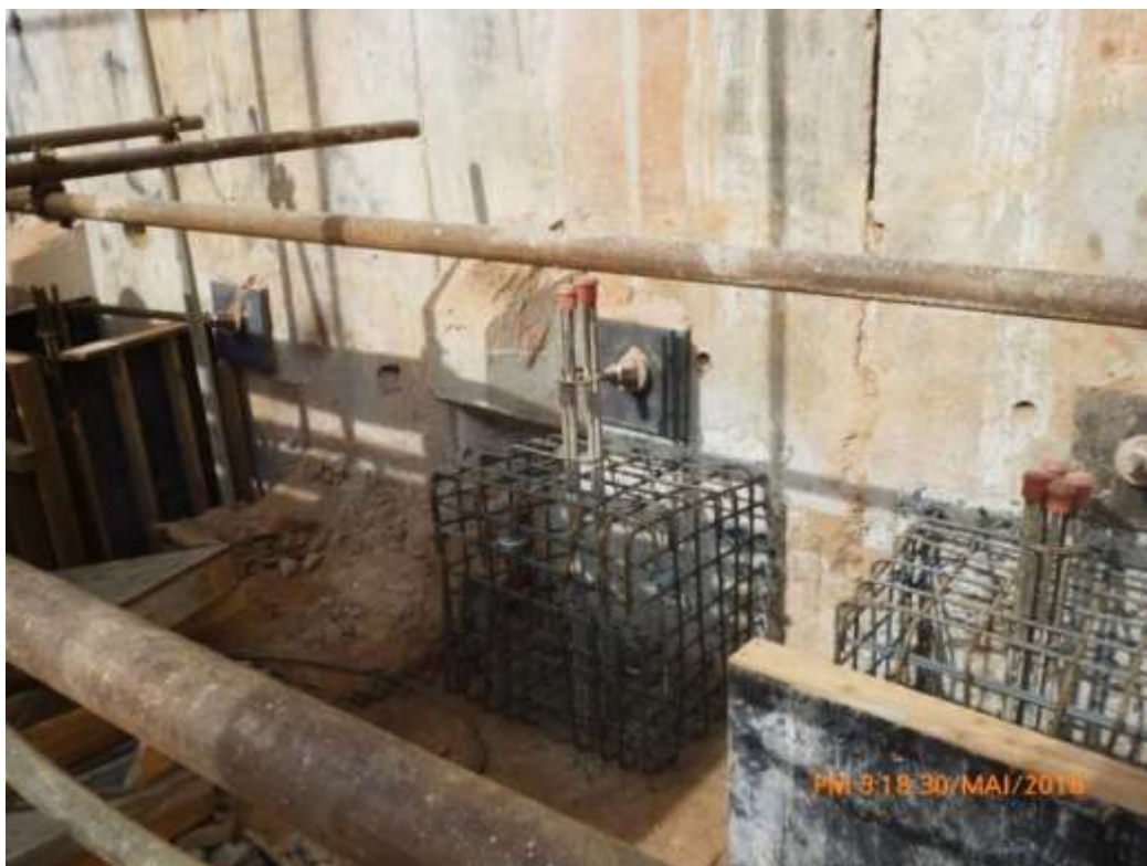
Figura 3-6 - Reforço da fundação com blocos e estaca raiz. (DEER, 2018).
