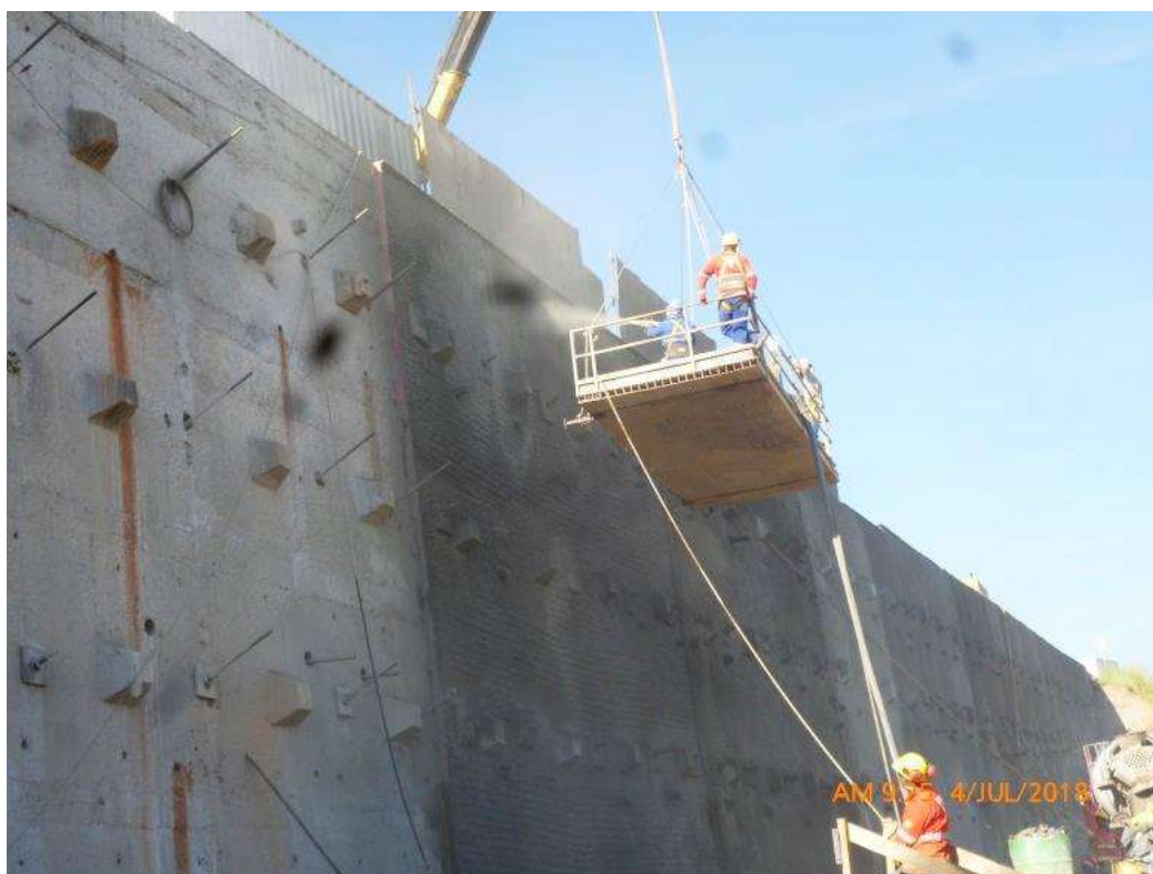
Figura 3-5 - Implantação de 308 novos tirantes e concretagem de 15 cm. (DEER, 2018).
