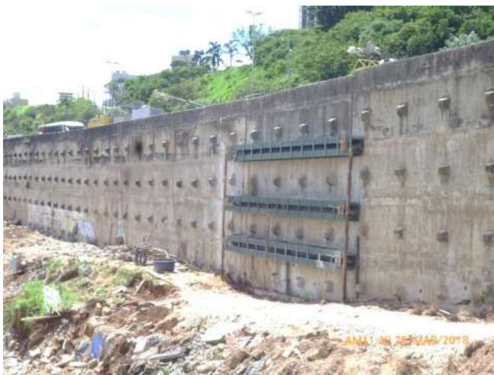
Figura 3-4 - Reforço provisório do painel 11 – Painel crítico (DEER, 2018).
