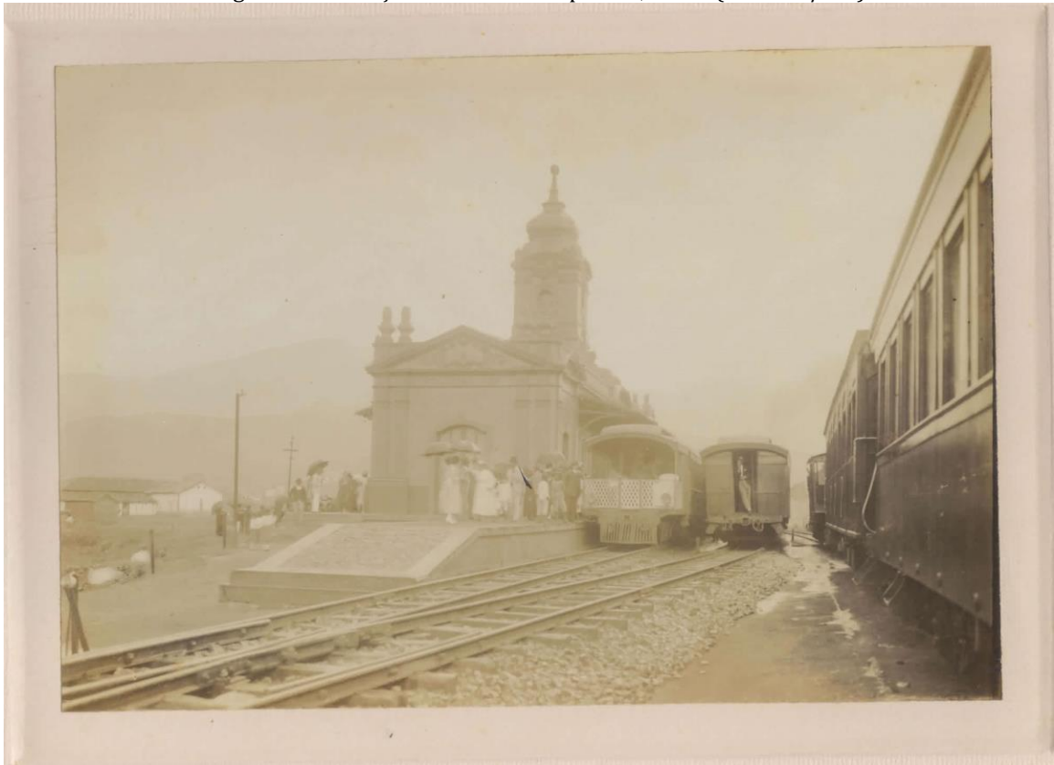
Fotografia XX. Estação central - vista parcial, 1922. (Mariana/MG).
