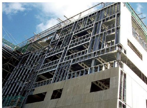
FIGURA 14 - Execução de painéis contínuos estruturados em LSF
