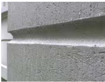
FIGURA 41 - Arranjos arquitetônicos executados na placa de isolamento: ranhuras abauladas executadas in loco (a), cornijas pré-fabricadas (b)
