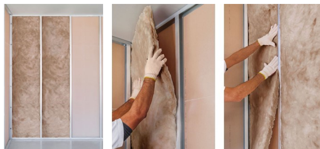
FIGURA 46 - Instalação de lã mineral em SVVEI estruturados em LSF
