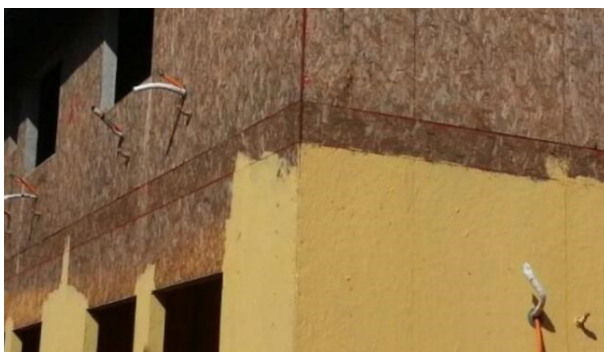
FIGURA 36 - Impermeabilização do substrato por meio de impermeabilizante líquido (a) e membrana não tecido (b)
