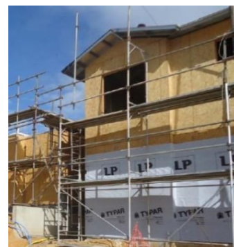
FIGURA 36 - Impermeabilização do substrato por meio de impermeabilizante líquido (a) e membrana não tecido (b)
