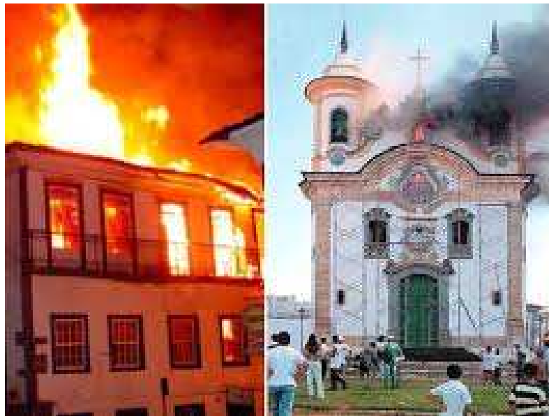
Figura 1.1: Incêndio em edificações históricas. (a) Pilão, praça Tiradentes – Ouro Preto, MG (2003). (b) Igreja Nossa Senhora do Monte Carmelo, Mariana – MG (1999).
