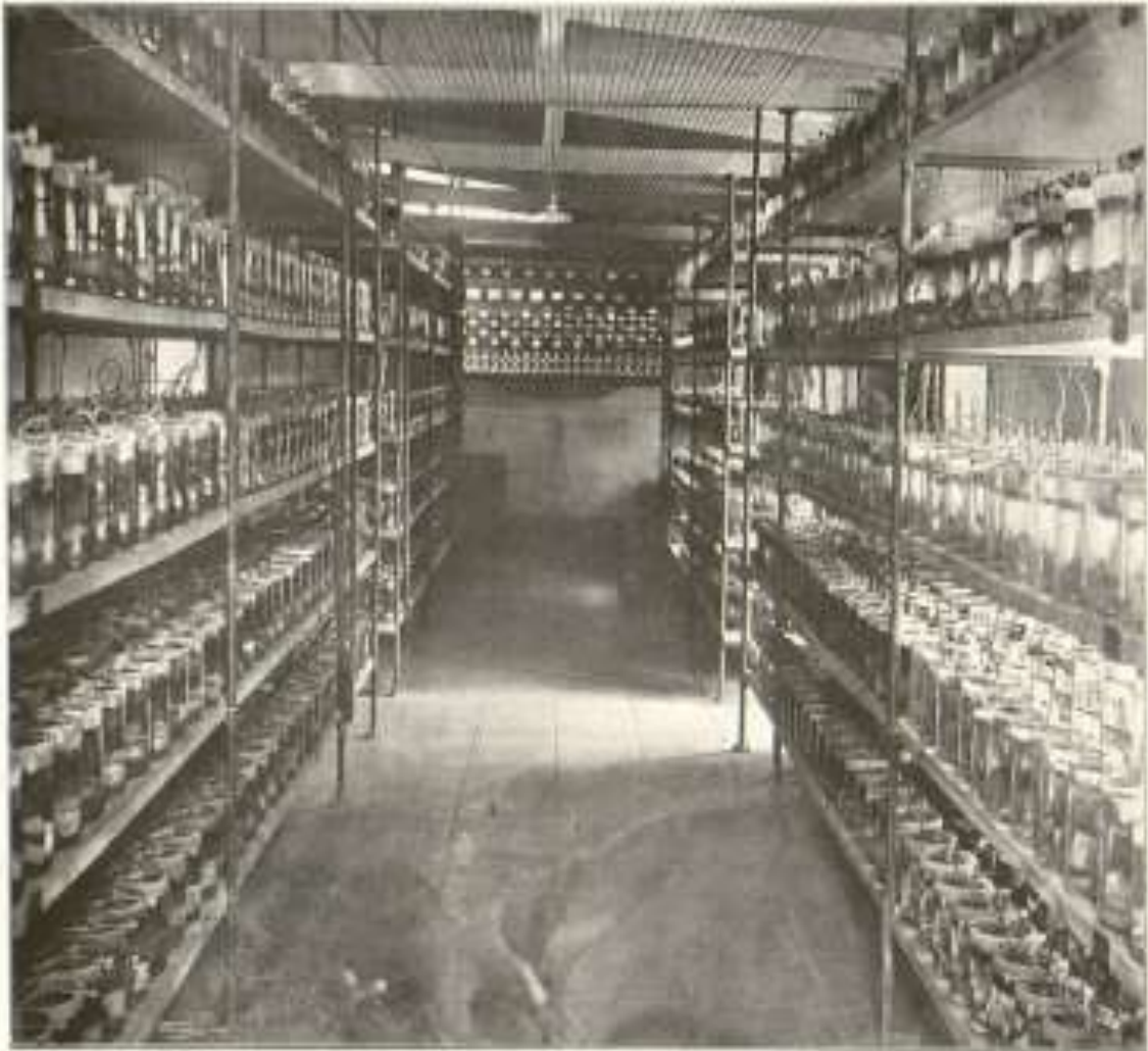
México — Telégrafo Federal. Sala de pilas
