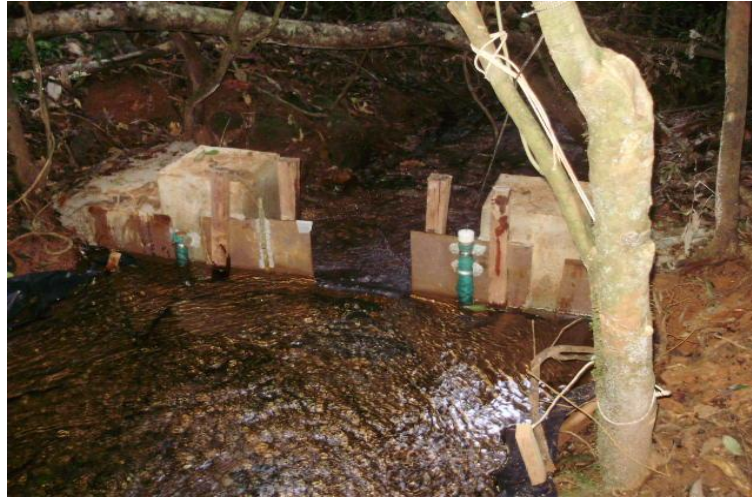
Figura 3.5 -Imagem do vertedouro instalado no córrego São Bartolomeu.
