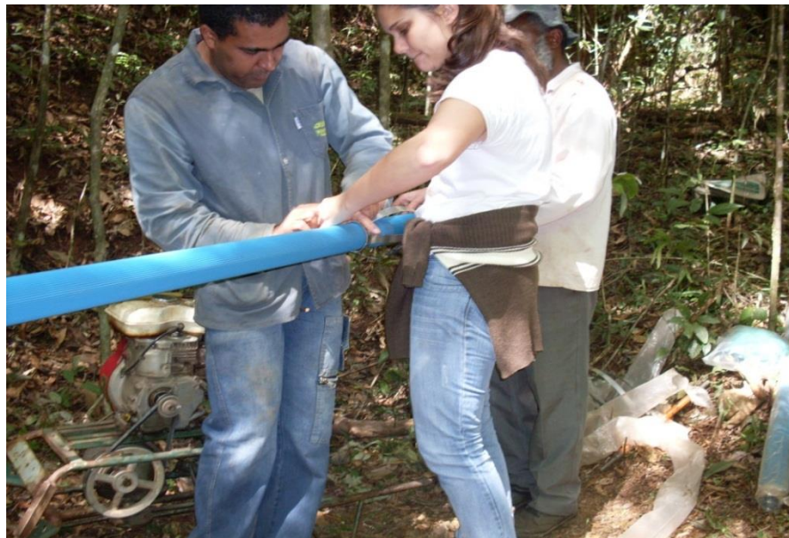
Figura 3.7- Instalação do indicador de nível d'água.
