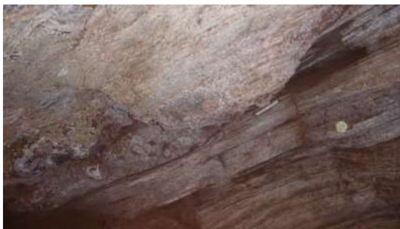
Figura 9.18 – Processo de deslizamento de placas de itabirito segundo o acamamento (S0).
