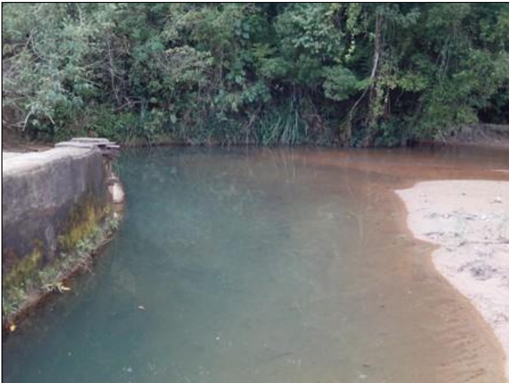
Figura 14: captação da ETA Vila Alegre
