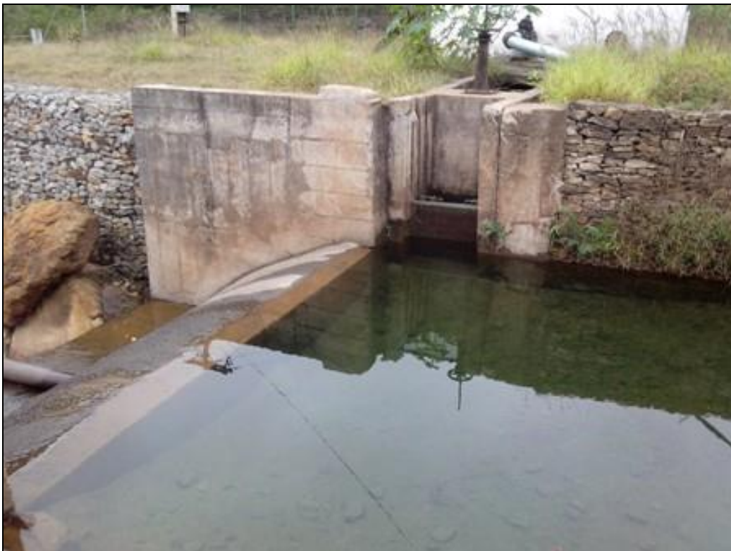
Figura 20: barragem da captação principal da ETA Antônio Pereira
