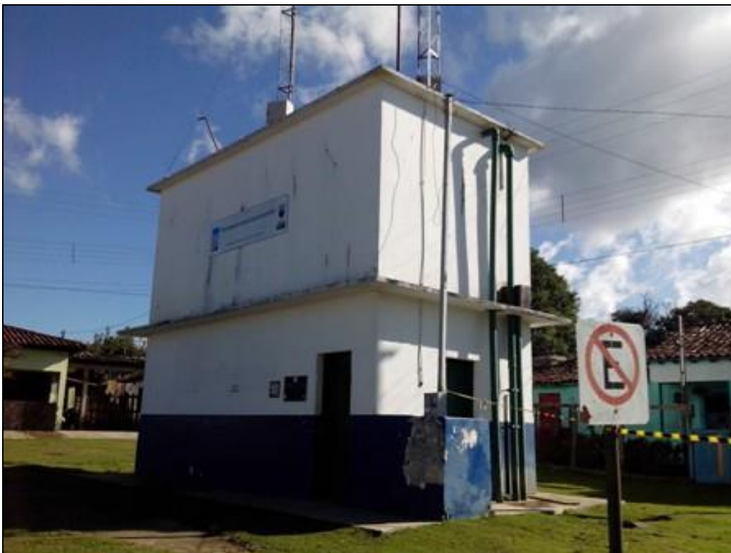
Figura 24: reservatório de concreto de Lavras Novas
