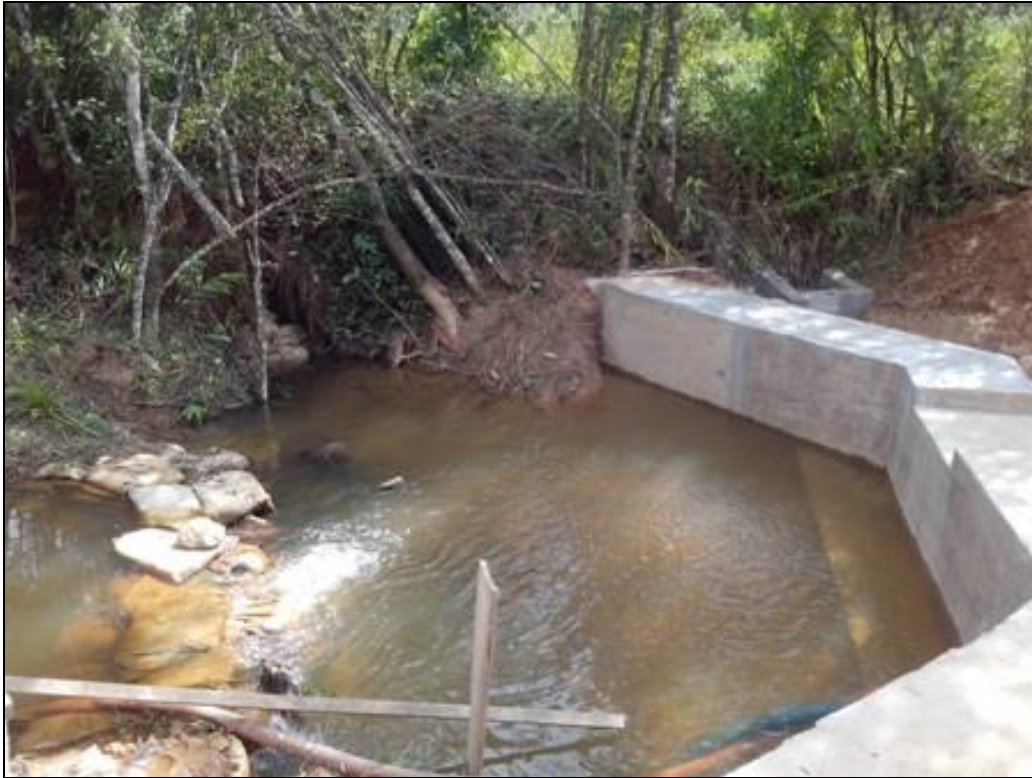
Figura 17: barragem de captação da ETA Amarantina
