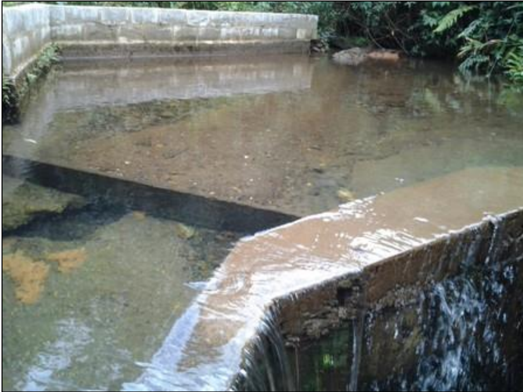
Figura 7: captação principal da ETA Jardim Botânico
