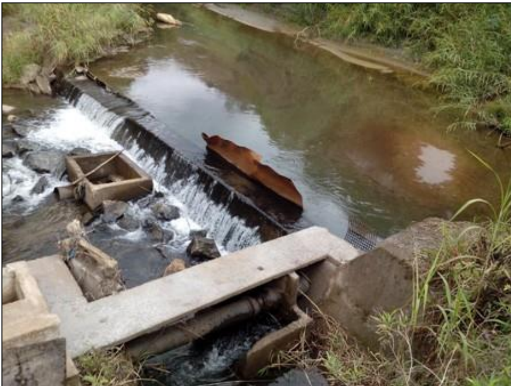
Figura 12: barragem de captação da ETA Funil
