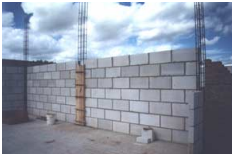
FIG. 2.11 - Alvenaria de fechamento com blocos de CCA (Fonte: SICAL, 2002)
