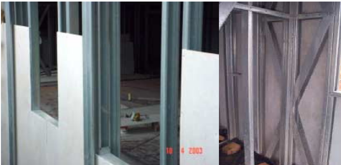
FIG. 2.25 - Vistas externa e interna de Steel-Frame com placas cimentícias
