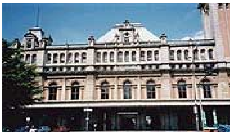
FIG. 2.2 – Estação Ferroviária da Luz (Fonte: SAMPACENTRO, 2003)
