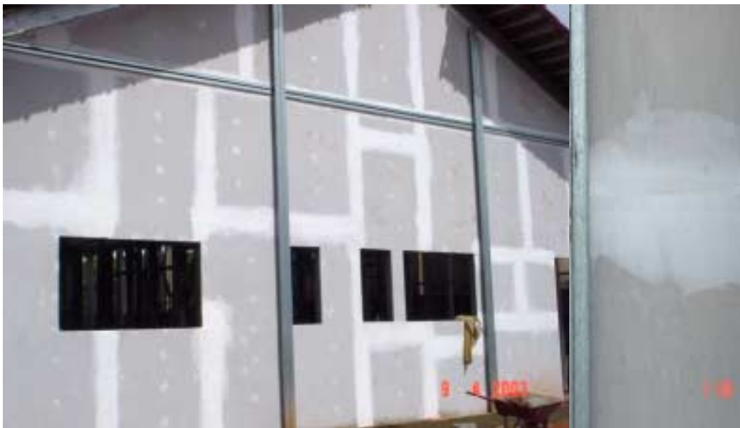
FIG. 2.27 - Fachada de edificação e detalhe da junta tratada com massa
