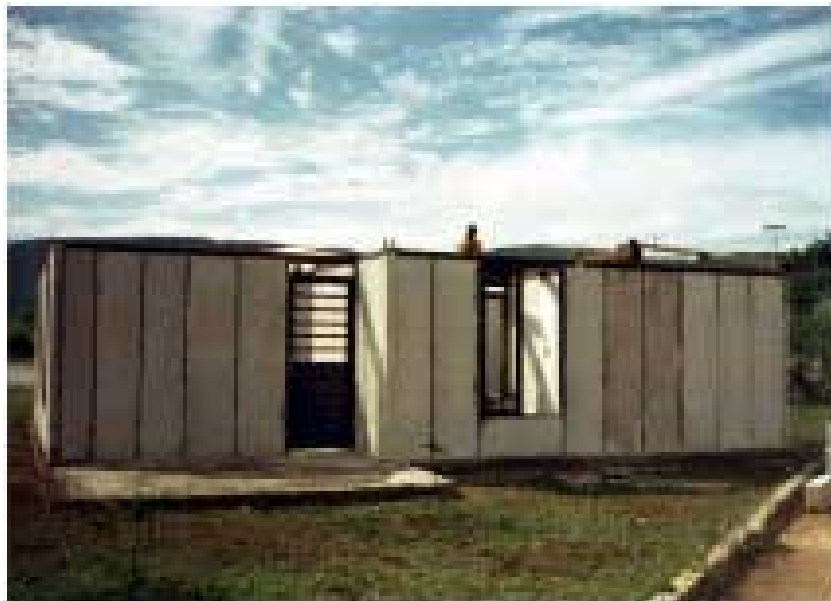
FIG. 2.17 – Painéis em fase de montagem (Fonte: SICAL, 2002)
