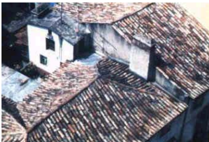
FIG. 2.29 - Telhado colonial português (Fonte: UTL, 2002)
