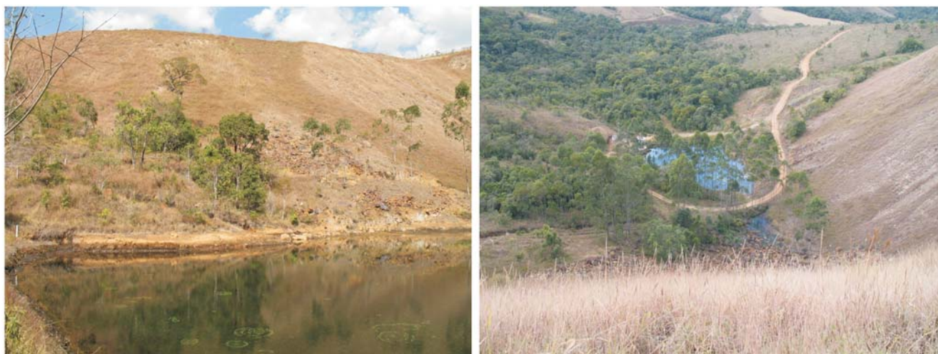
Figura 1 - Vista da base do BF-4 (esquerda) e vista do topo do BF-4 (direita) tendo ao fundo a bacia de captação da drenagem oriunda do BF-4.
