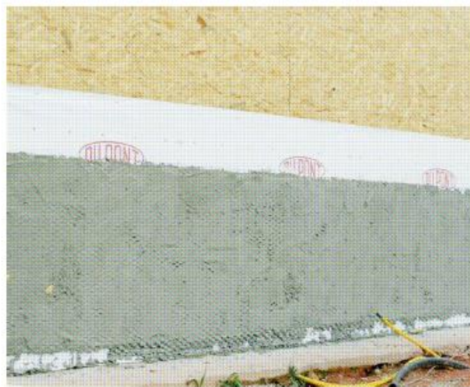
Figura 2.14 - Revestimento das placas de OSB com argamassa aplicada sobre tela de galinheiro.
