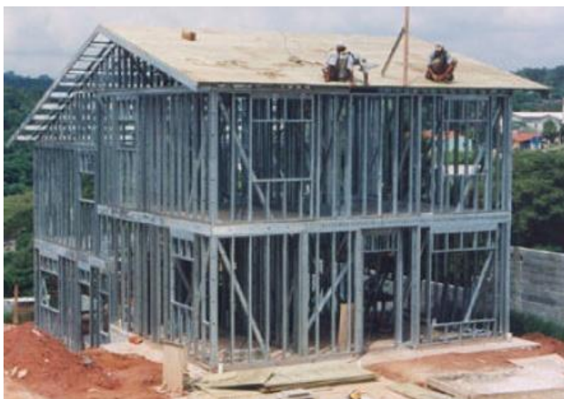
FIGURA 1.1 – Residência sendo construída em Light Steel Framing .
