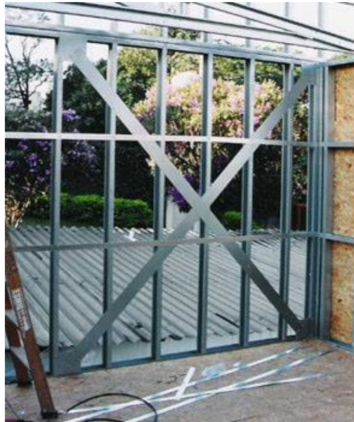
Figura 2.3 – Painel com contraventamento.
