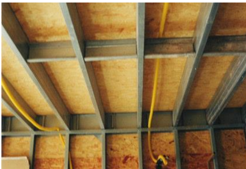
Figura 2.5 – Vigas de piso e contrapiso em OSB.
